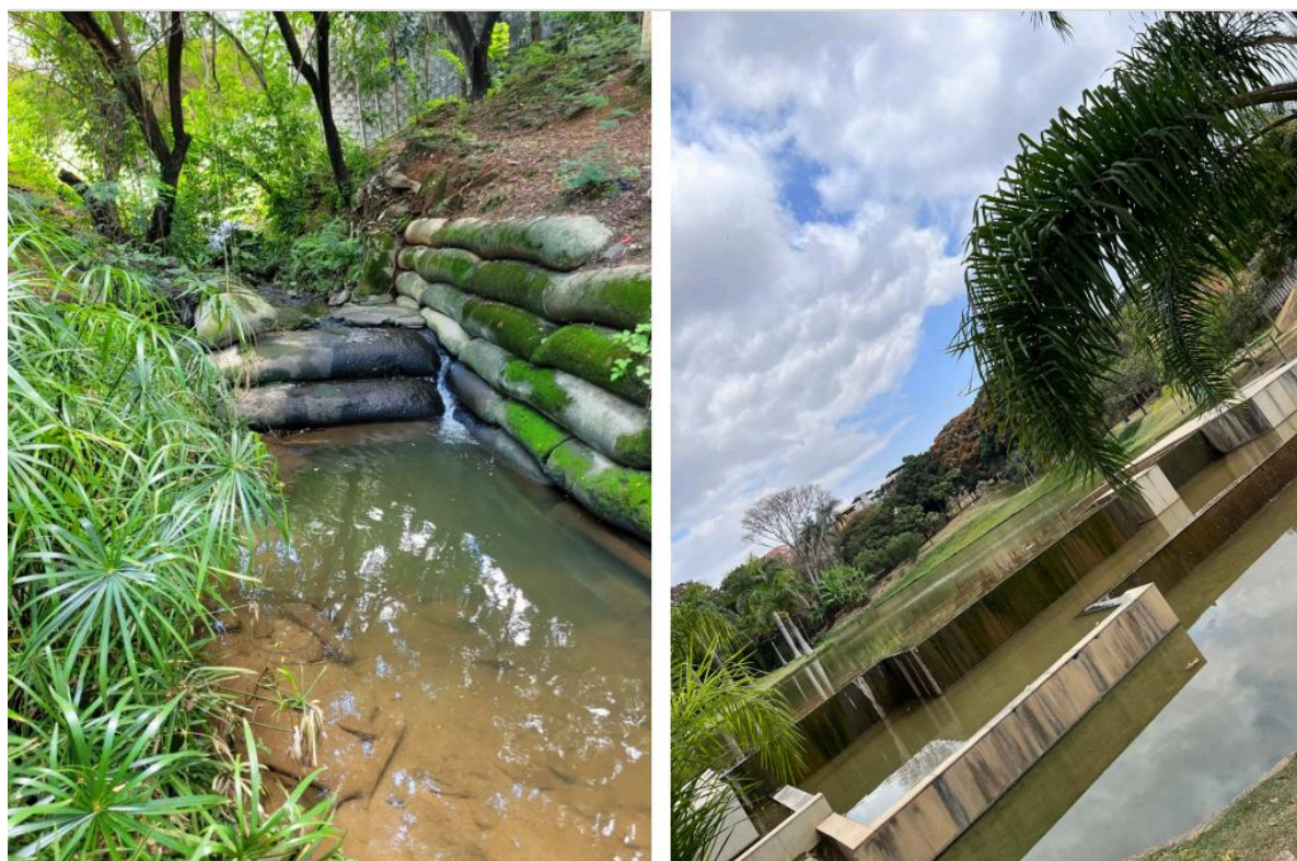
Figura 12: Ponto de coleta do curso d'água e vista para montante, onde há uma bacia de contenção para atenuação das cheias.
