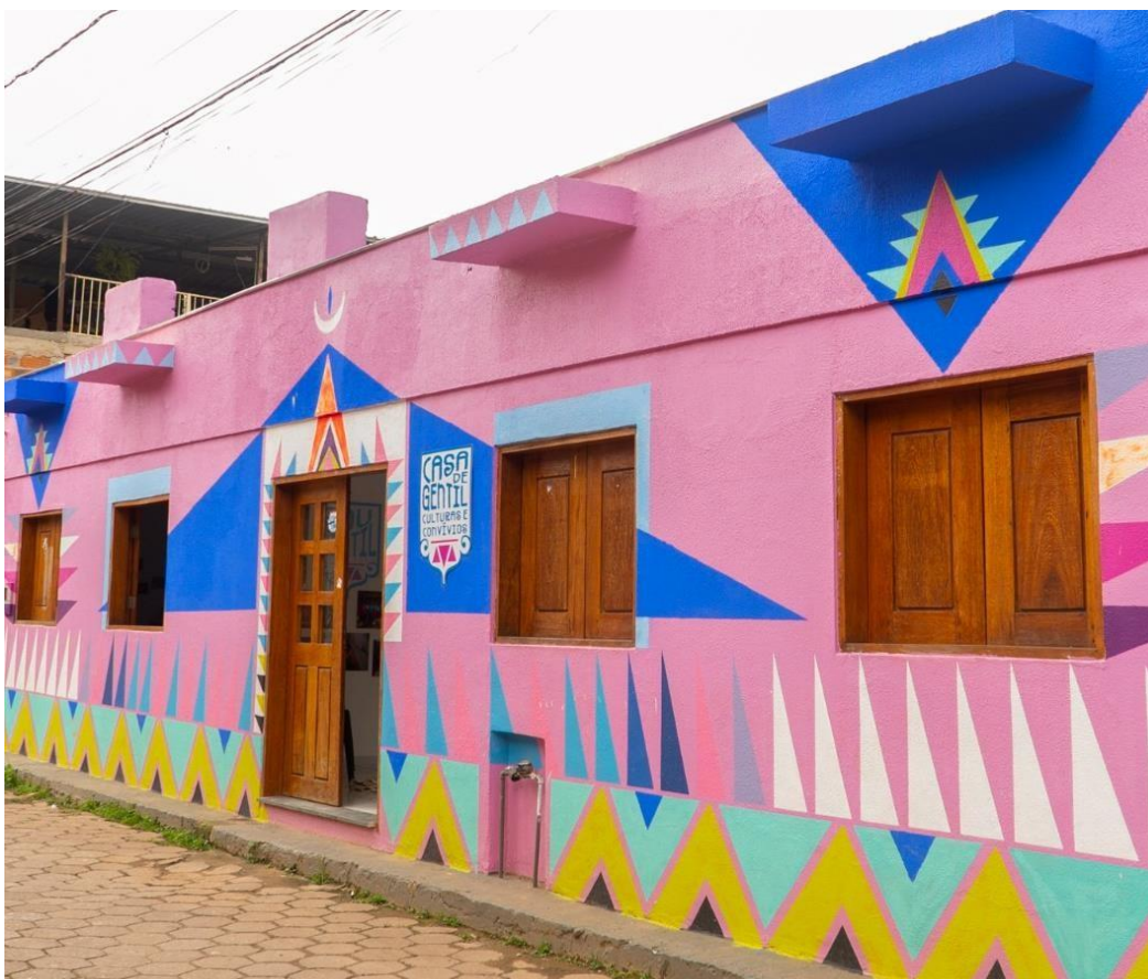
Figura 6 – Foto da fachada da terceira Casa de Gentil, depois da reforma após a enchente de 2022
