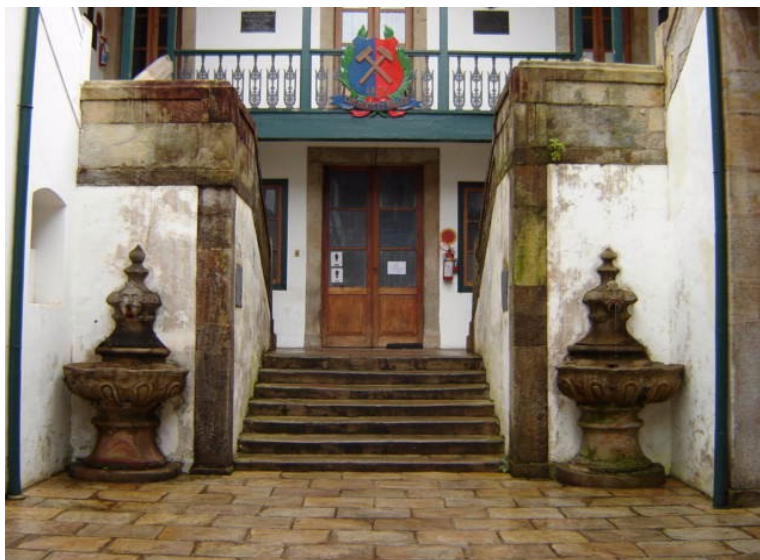
Figura III.1: Aplicações de quartzitos Itacolomi, no pátio interno do atual Museu de Ciência e Técnica, Antigo Palácio do Governador, Escola de Minas, Ouro Preto
