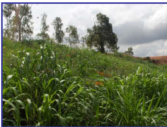
Figura 5.20 – Talude no final do projeto na área de campo vista 1
