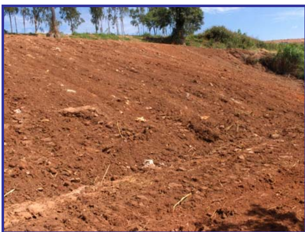
Figura 5.16 – Talude desnudo antes da instalação das parcelas experimentais na área de campo
