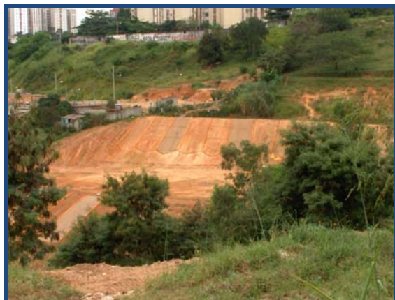
Figura 5.8 – Vista geral de taludes com parcelas experimentais na área da favela
