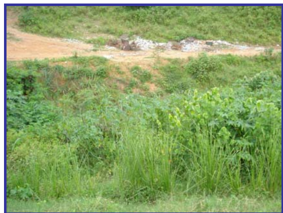
Figura 5.12 – Talude no final do projeto na área da favela aterro. Capim vetiver e presença de mamona como planta invasora
