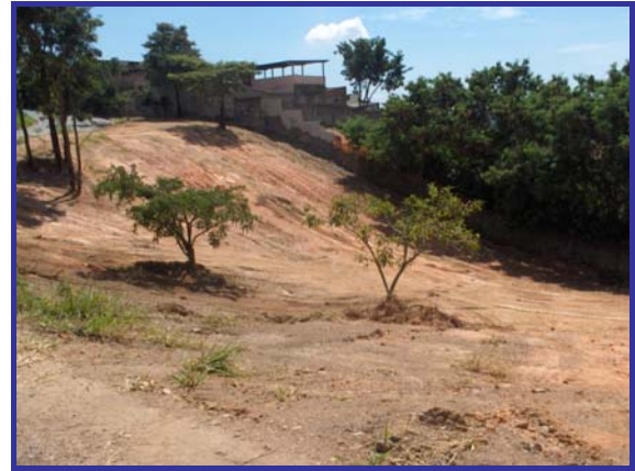
Figura 5.23 – Talude desnudo antes da instalação das parcelas experimentais na área da escola vista 2
