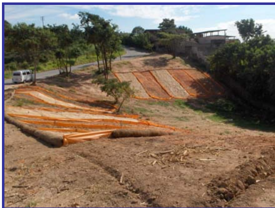
Figura 5.24 – Vista geral de taludes com parcelas experimentais na área da escola
