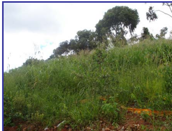
Figura 5.21 – Talude no final do projeto na área de campo vista 2
