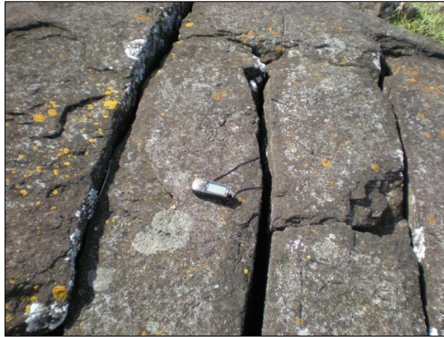
Figura 3.38: Fraturas observadas no CISA. Fonte: Zanon (2009).
