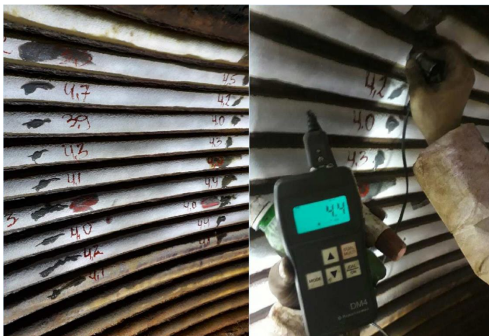
Figura 4. 20 – Foto da superfície interna do duto durante a medição de espessura, mostrando valores encontrados de espessura em cada ponto (Fonte: Imagens cedidas pela empresa SMS group).
