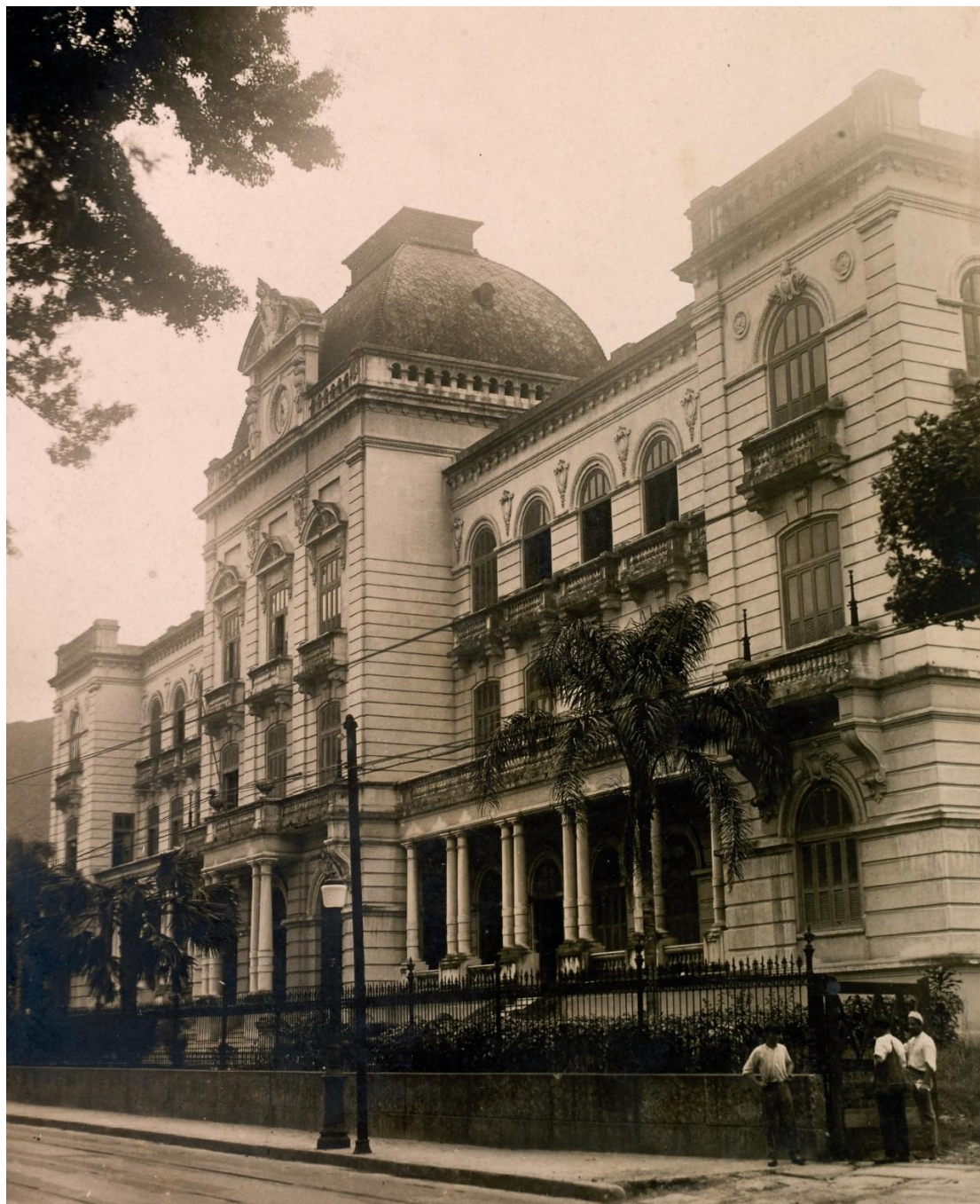
Figura 3 – Prédio principal do INES
