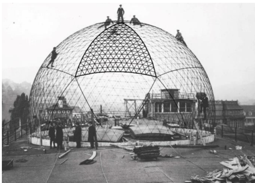
Figura 4 - Subdivisões triangulares na cúpula do primeiro planetário Zeiss (1923)
