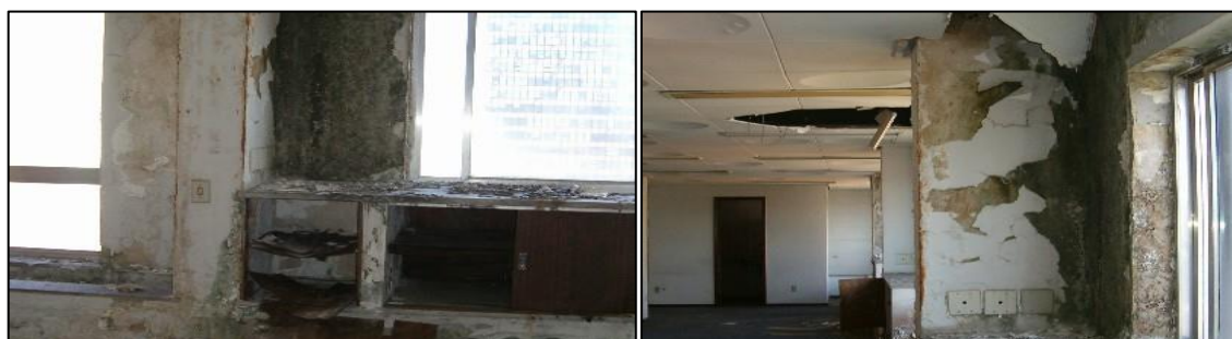
Figura C3: Fotos do interior- antes do retrofit .
