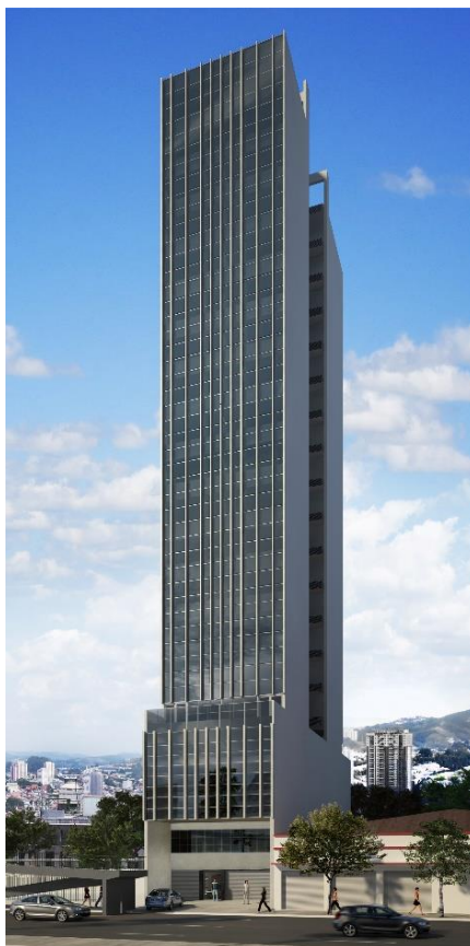
Figura G2: Central Tower - Rua Rio de Janeiro, 37 - Centro.
