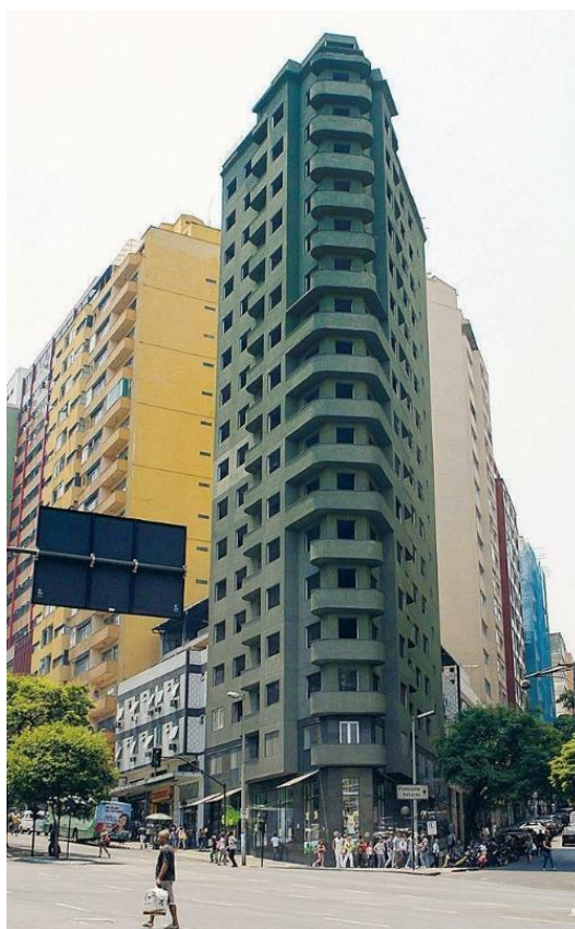
Figura 29: Foto da fachada de esquina do Edifício Tupis até paralização da obra.
