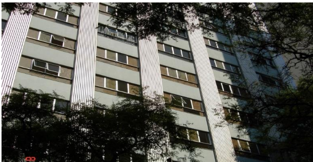
Figura 28: Foto da fachada - rua São Paulo - Edifício Chiquito Lopes - após retrofit .
