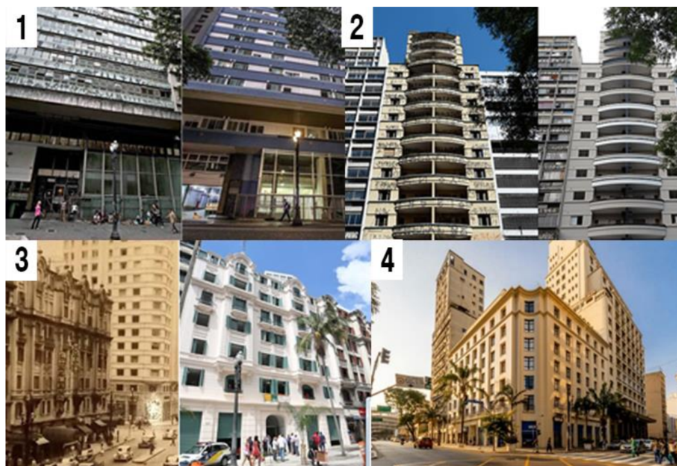
Figura 8: Prédios retrofitados SP.
