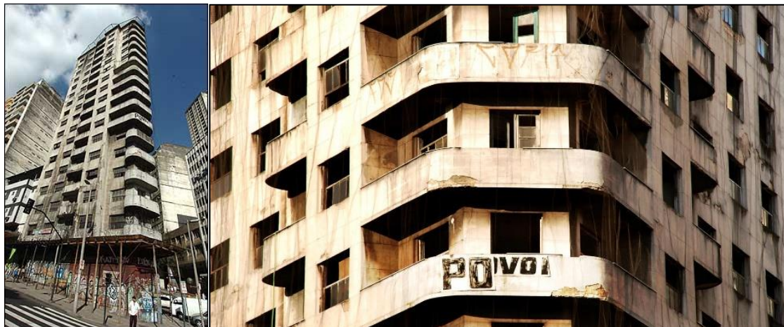
Figura D1: Fachada rua - Avenida Amazonas com rua Tupis - antes retrofit .
