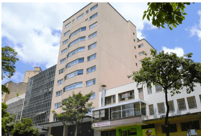
Figura H11: Prédio retrofitado localizado na avenida Afonso Pena, 342 - Centro.
