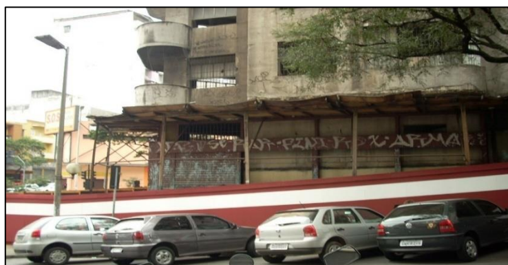
Figura D3: Foto rua Tupis - loja - antes retrofit .
