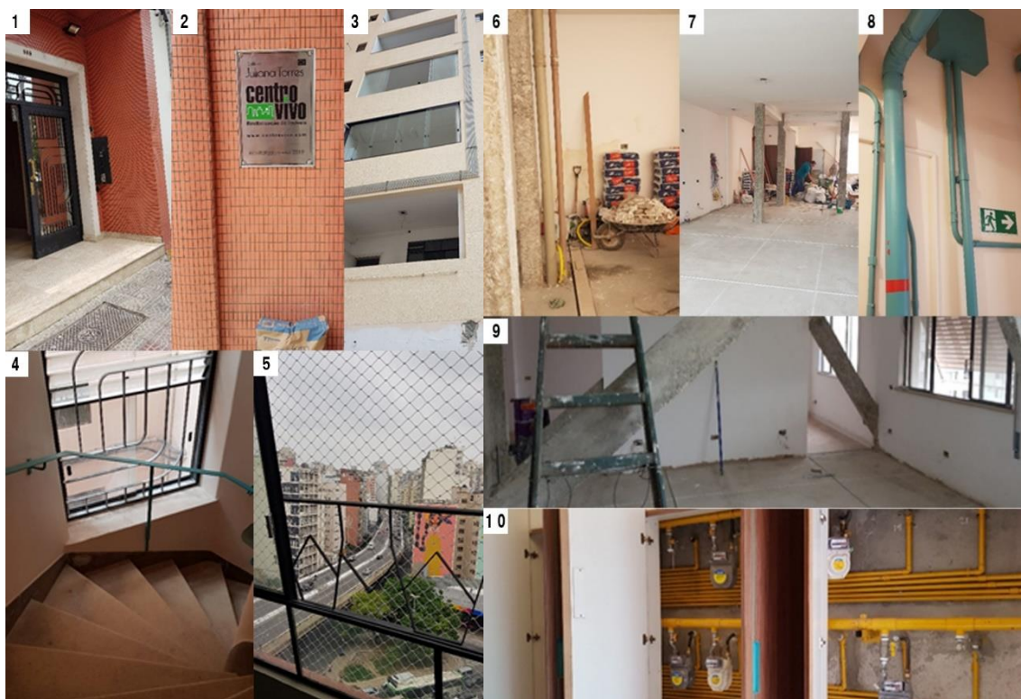
Figura 10: Edifício retrofitado Juliana Torres - SP.
