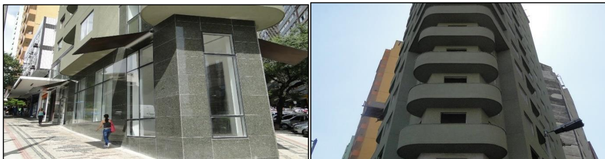
Figura D5: Fachadas em finalização.
