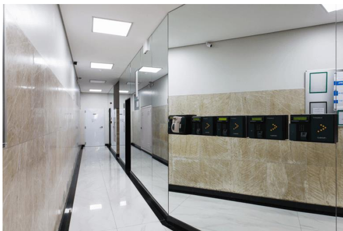
Figura H10: Interior do prédio retrofitado na avenida Álvares Cabral, 217 - Centro.
