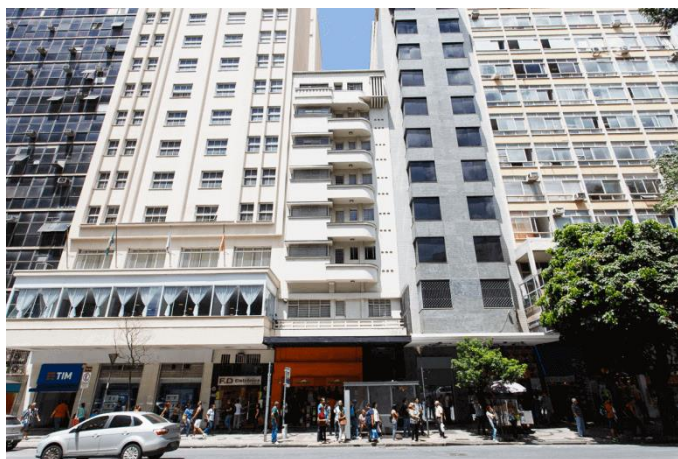
Figura H5: Prédio retrofitado na avenida Afonso Pena, 774 - Centro.
