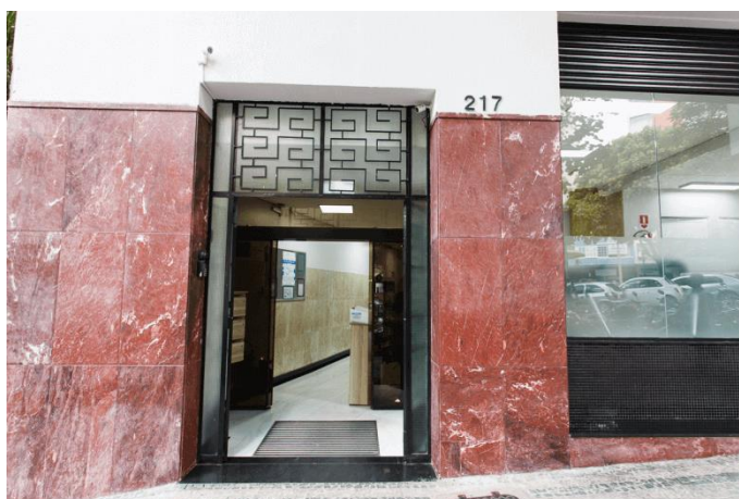
Figura H9: Detalhe da porta de entrada no prédio retrofitado na avenida Álvares Cabral, 217 - Centro
