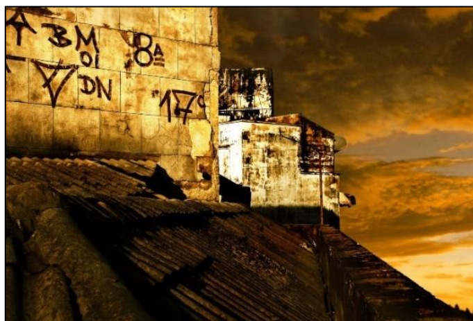
Figura D2: Detalhe da Fachada fundos.
