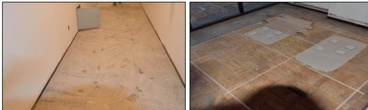
Figura E3: Recuperação pisos - mármore e tacos.
