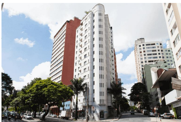
Figura H3: Prédio retrofitado na rua Rio Grande do Sul, 661 - Barro Preto.
