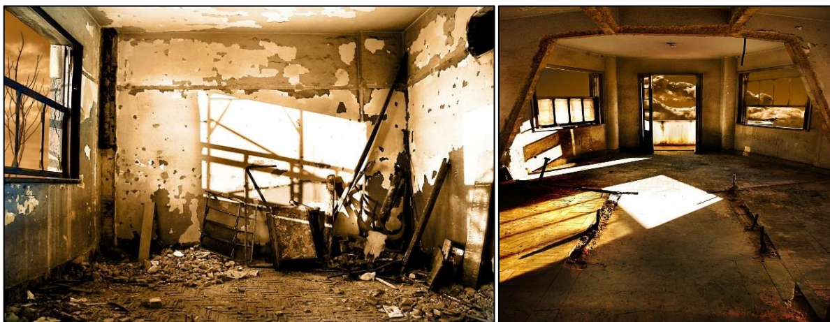
Figura D4: Foto interior prédio - antes retrofit .
