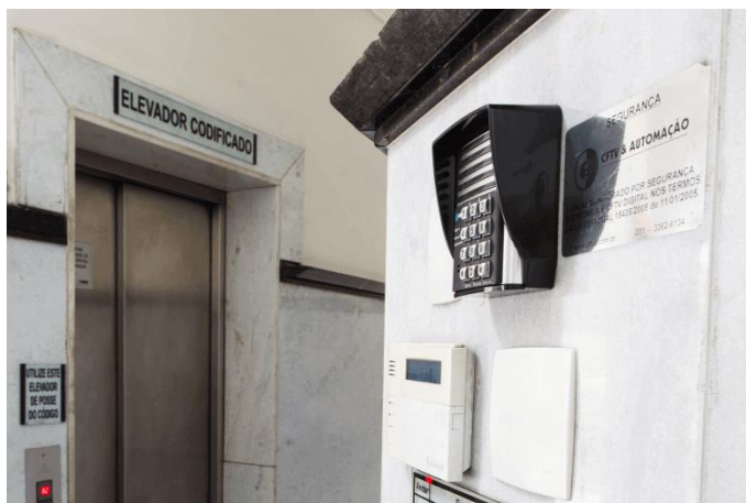
Figura H4: Interior prédio retrofitado na rua Rio Grande do Sul, 661 - Barro Preto.
