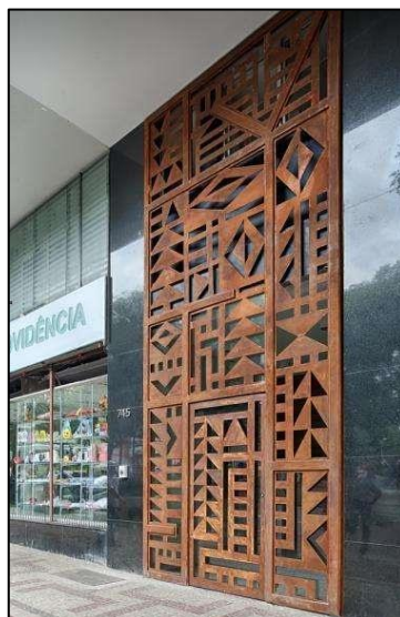
Figura E6: Porta entrada do Edifício Excelsior Residence.
