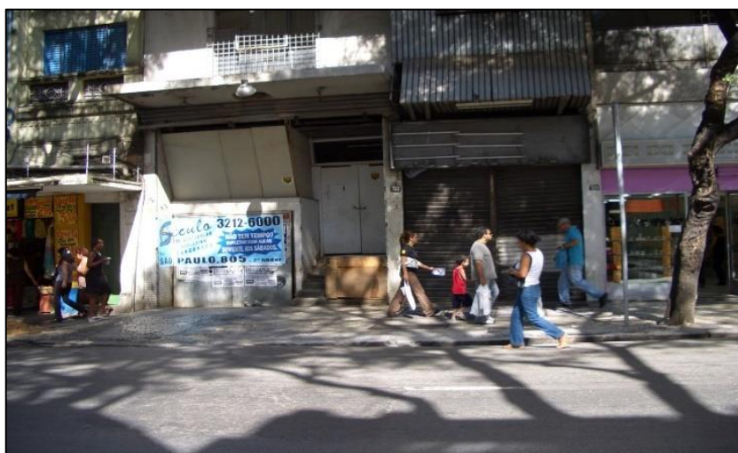
Figura C2: Foto da fachada antes do retrofit .
