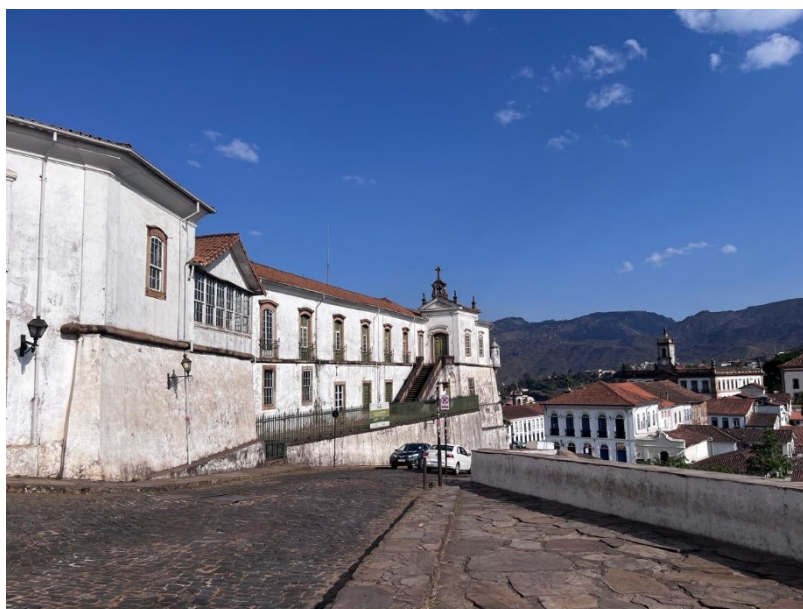
Figura 6 - Vista panorâmica da lateral do edifício histórico da Escola de Minas da UFOP
