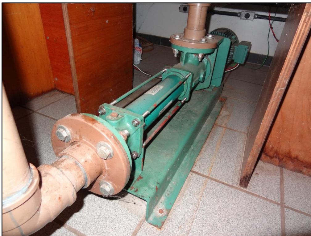
Figura 4.9 – Motobomba de cavidade progressiva
