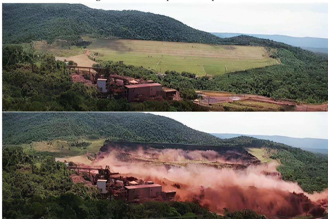
Figura 5. Antes e depois do rompimento.
