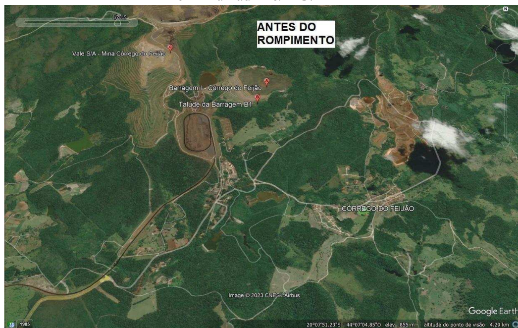
Figura 6. Imagem antes do rompimento da barragem B1, da Mina do Córrego do Feijão em Brumadinho/MG.
