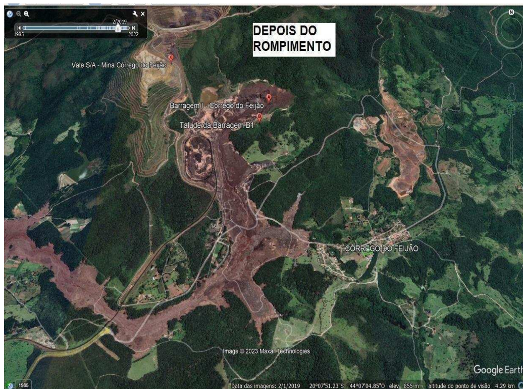
Figura 7. Imagem depois do rompimento da barragem B1, da Mina do Córrego do Feijão em Brumadinho/MG.
