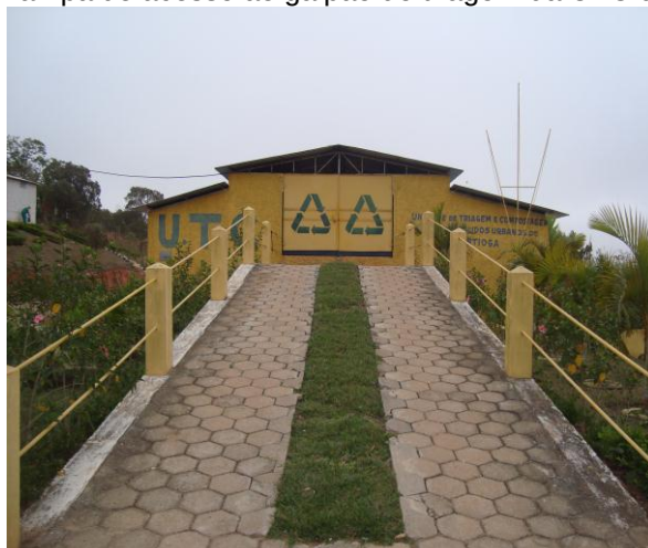
FIGURA 17: Rampa de acesso ao galpão de triagem da UTC do município “D”
