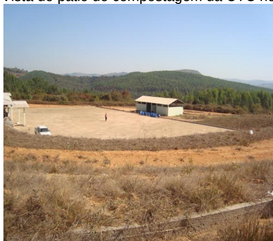
FIGURA 26: Vista do pátio de compostagem da UTC no município “F”
