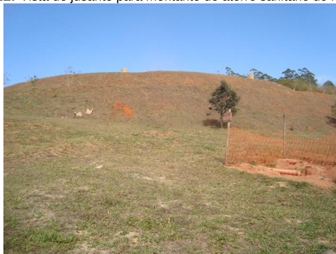
FIGURA 11: Vista de jusante para montante do aterro sanitário do município "A"
