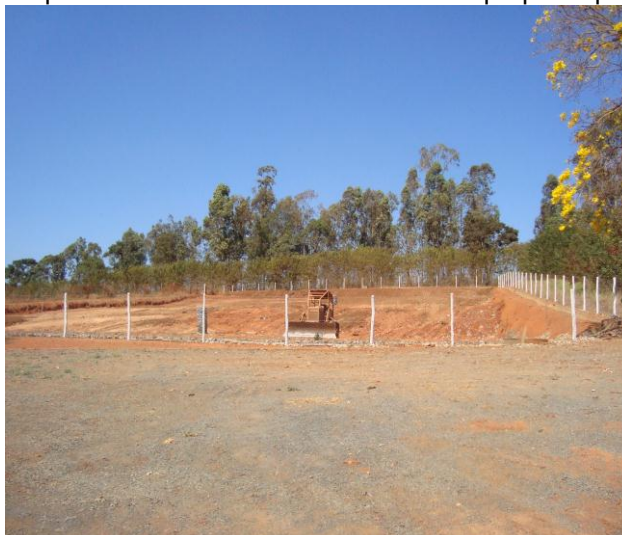
FIGURA 15: Vista de jusante para montante do aterro sanitário de pequeno porte no município “C”
