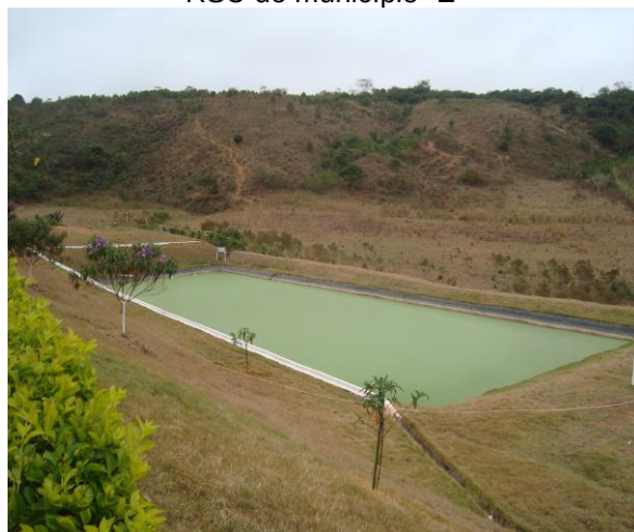
FIGURA 24: Vista do sistema de tratamento de lixiviados do sistema de tratamento e disposição final de RSU do município “E”
