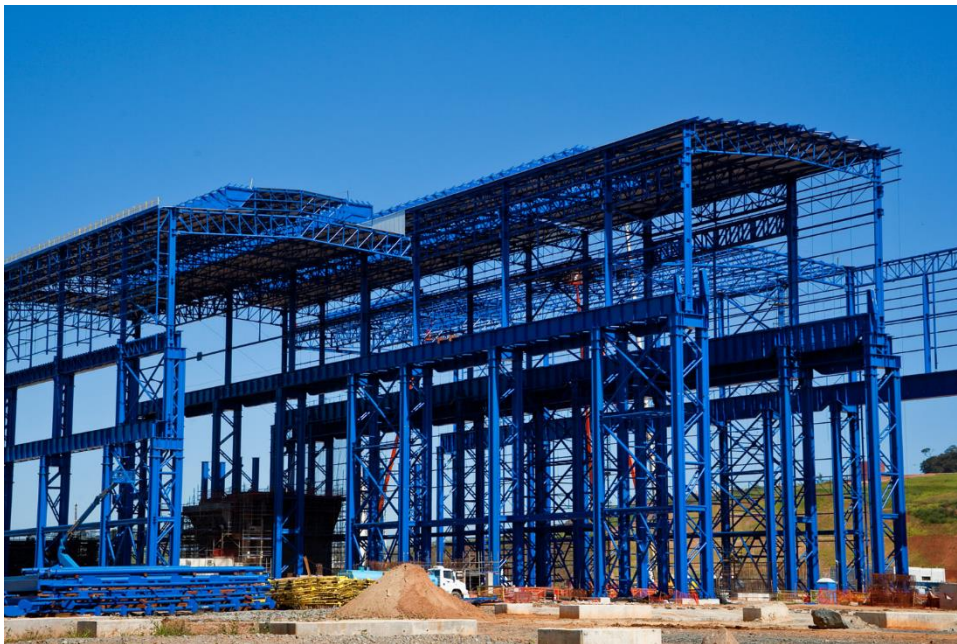
Figura 1.3. Estrutura da Aciaria da Vallourec e Sumitomo Tubos do Brasil em Jeceaba (MG) (www.vallourec.com, 2017)
