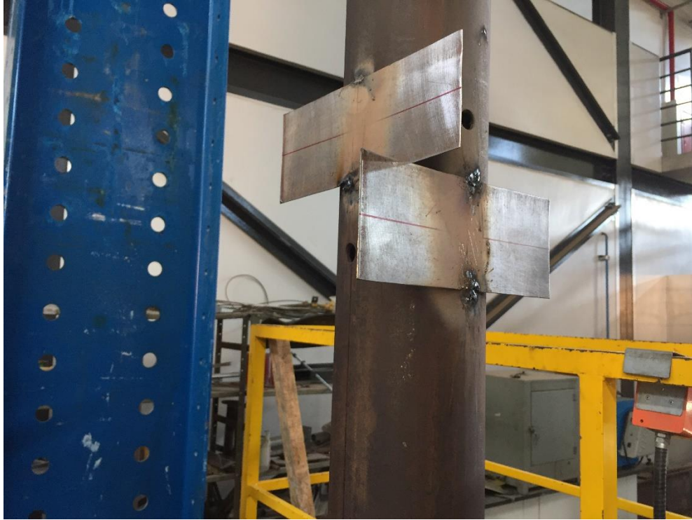
Figura 4.26. Chapas soldadas ao tubo externo.
