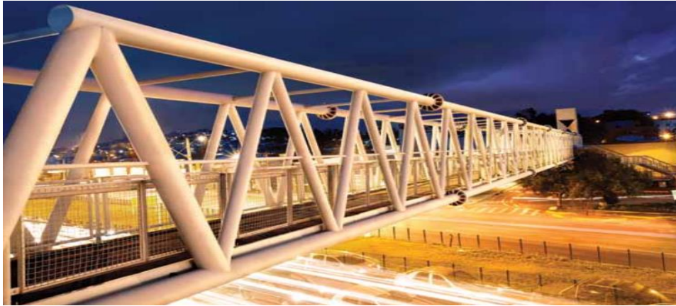
Figura 1.2. Estrutura tubular em passarela de pedestres em Belo Horizonte (MG) (www.vallourec.com, 2017)
