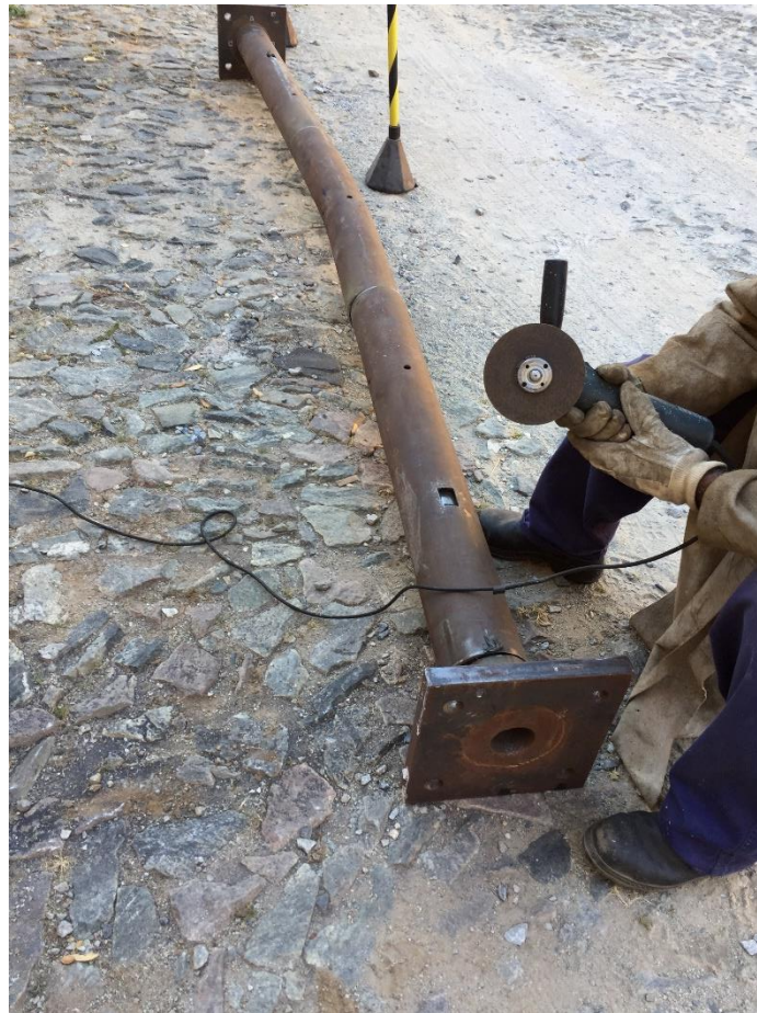
Figura 4.8. Execução dos cortes com serra elétrica.
