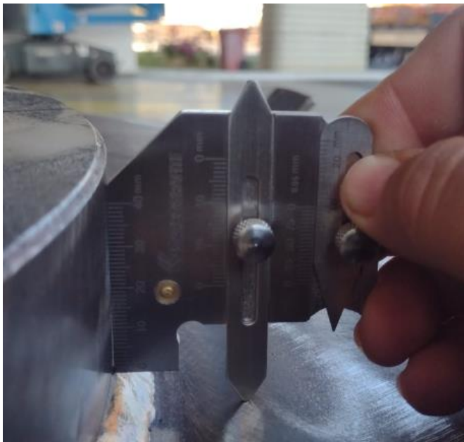
FIGURA 5 – Inspeção Visual de solda – Verificação dimensional da perna da solda.
