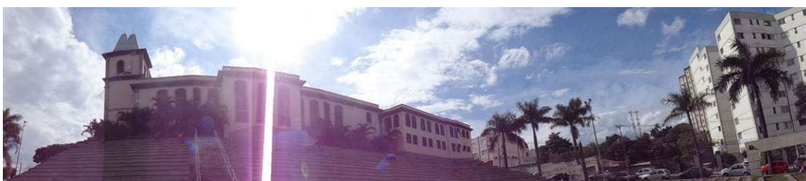
Figura 66: impacto das torres ao lado da Igreja.
