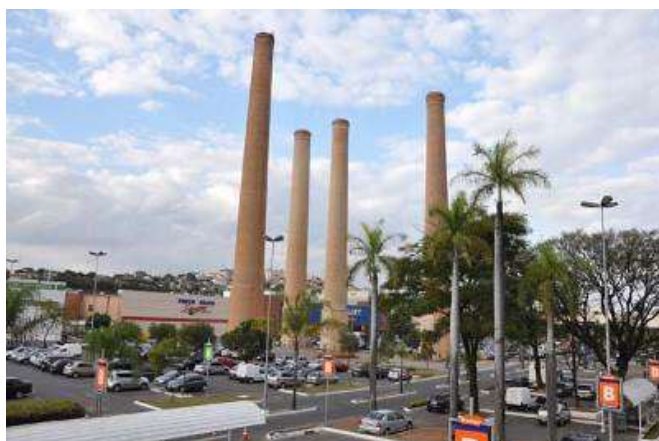
Figura 78: Chaminés do Complexo do Itaú.
