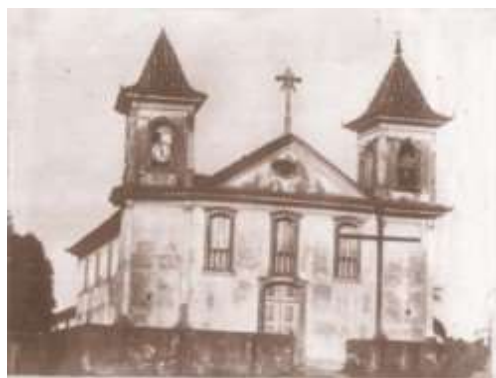
Figura 30: Igreja de São Gonçalo, década de 1920 -2ª Contagem.
