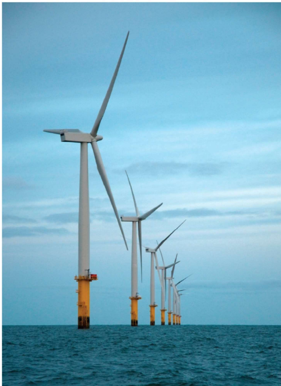
Figura 25 – Parque Eólico Offshore de Rhyll Flats 25 x 3,6 MW Turbinas Siemens [5]
