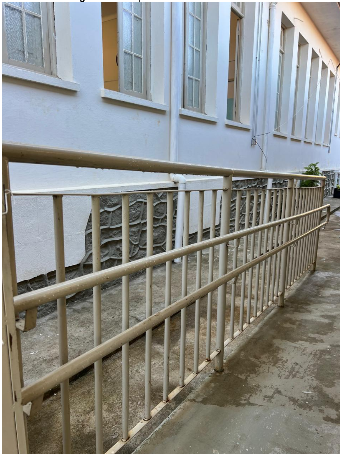
Figura 22- Rampa de acesso à sala de recursos
