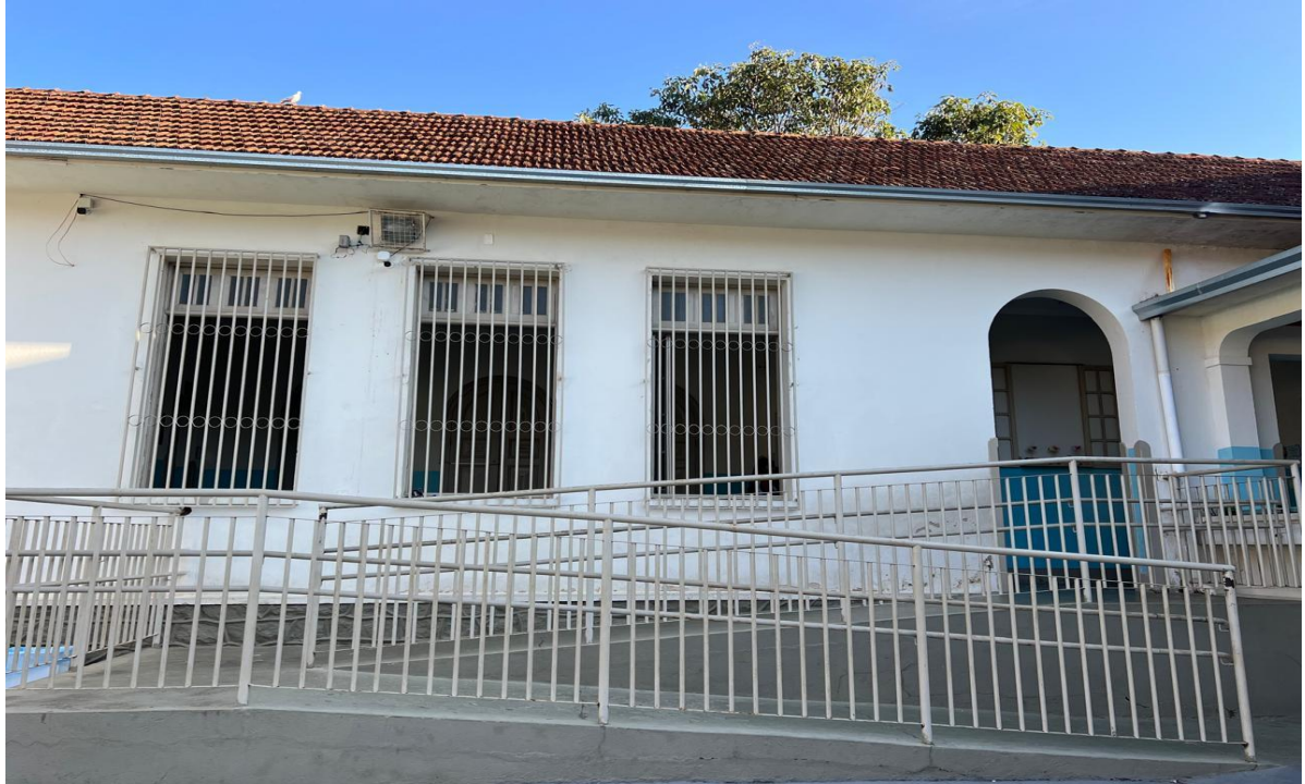
Figura 16- Rampas de acesso na escola
