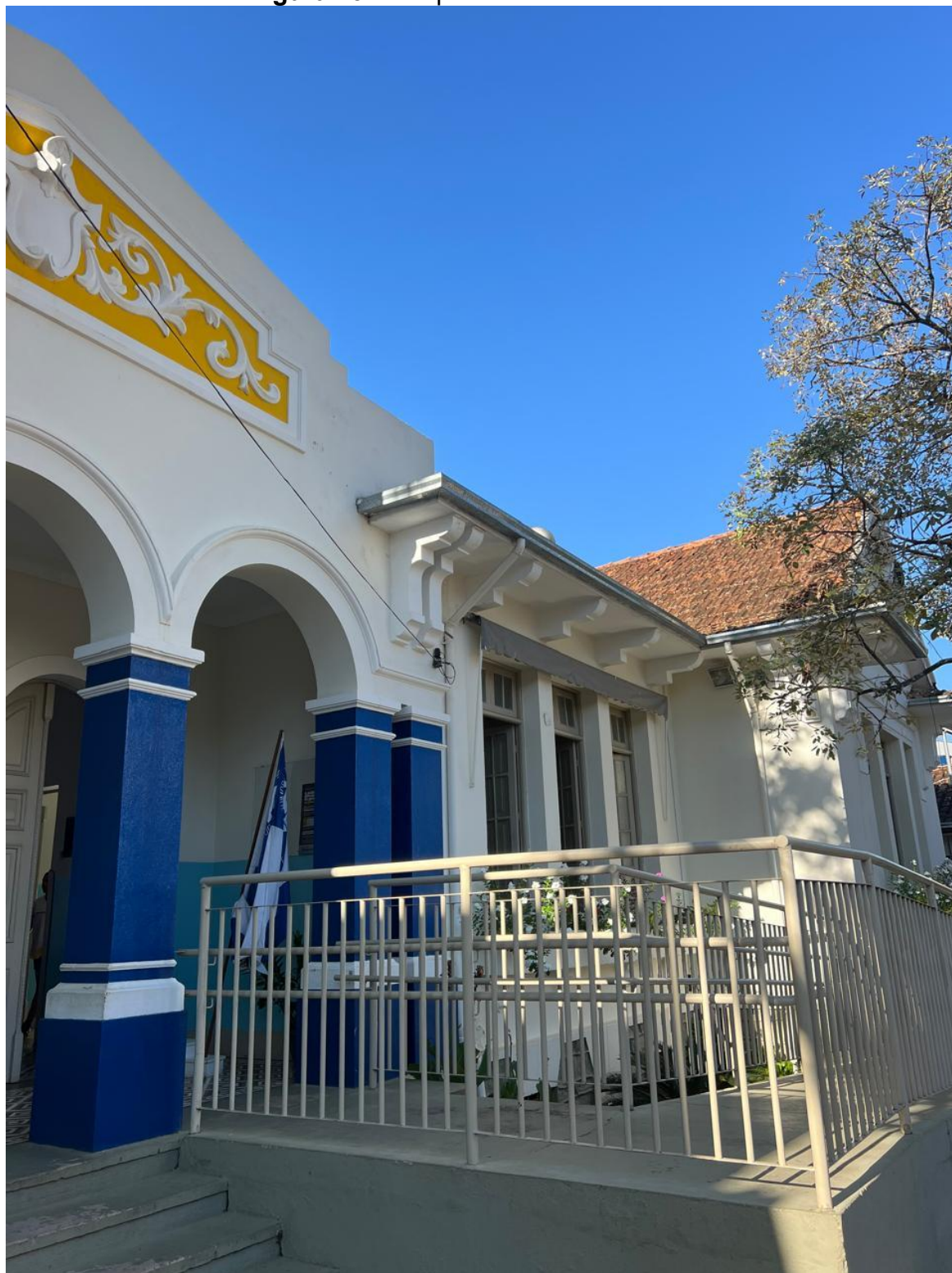
Figura 19- Rampa da entrada da escola
