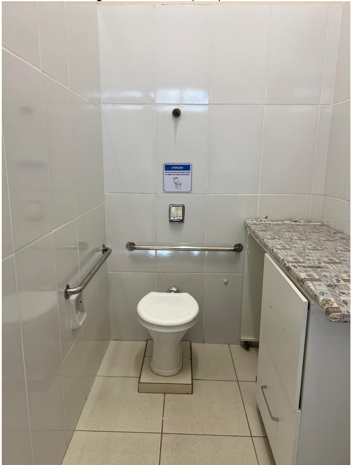
Figura 25- Banheiro adaptado para PCDs
