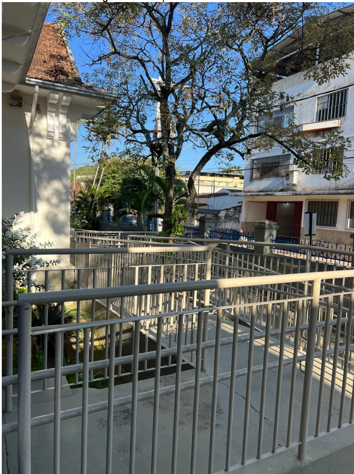
Figura 20- Rampa da entrada da escola
