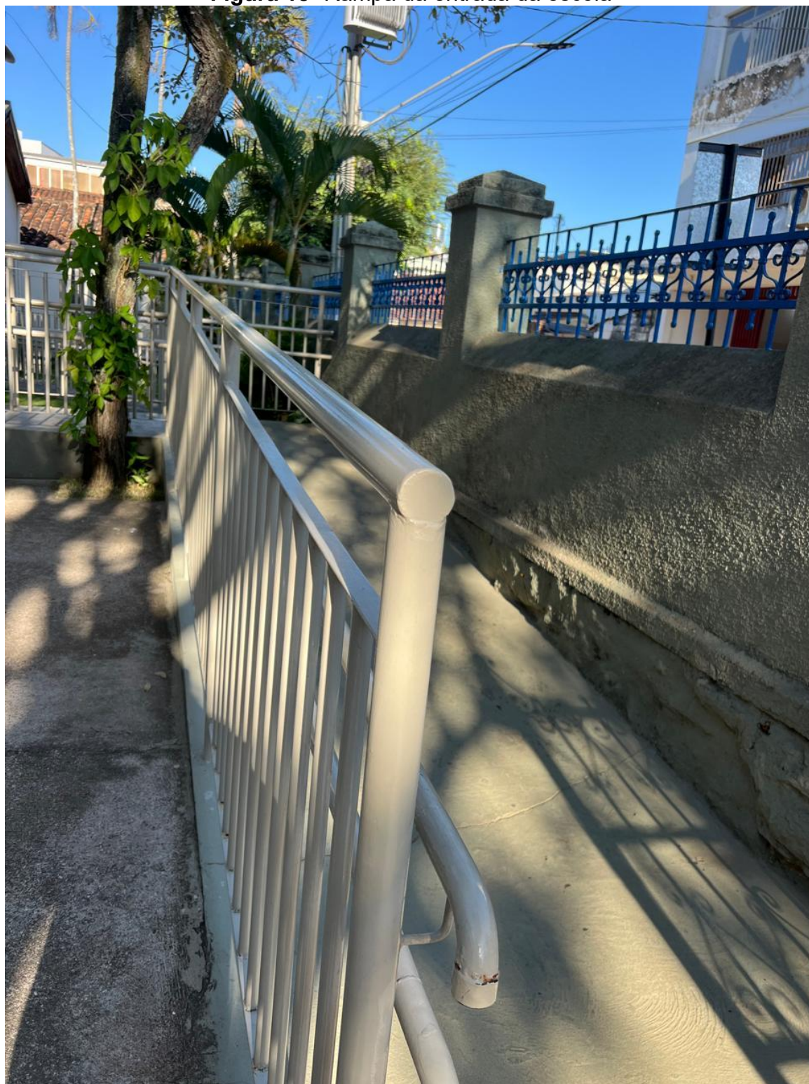
Figura 18- Rampa da entrada da escola
