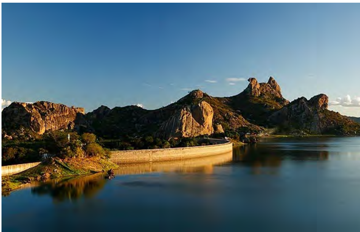
Figura 5 – Açude Cedro, a primeira Barragem construída no Brasil
