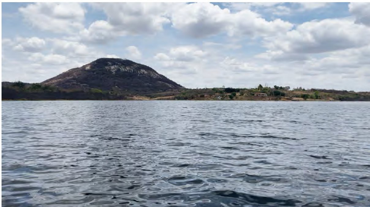
Figura 6 – Barragem do Patu
