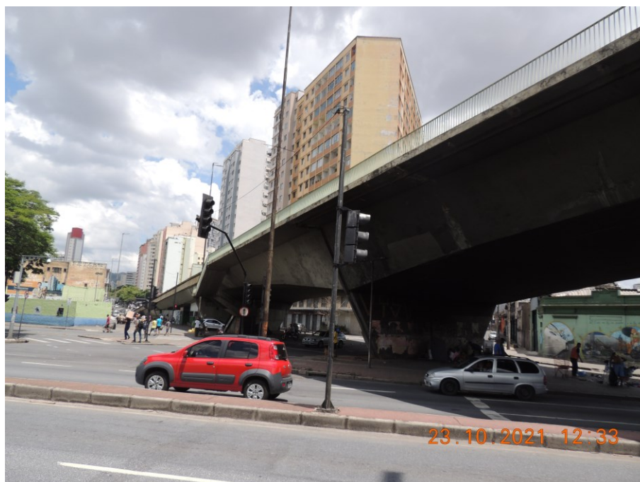
Figura 11. Vista lateral do viaduto Dona Helena Greco.
