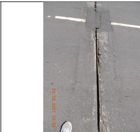
Figura 23. Falhas na vedação das juntas de dilatação favorecem a percolação de água pela estrutura do viaduto Santa Tereza (vista superior)
