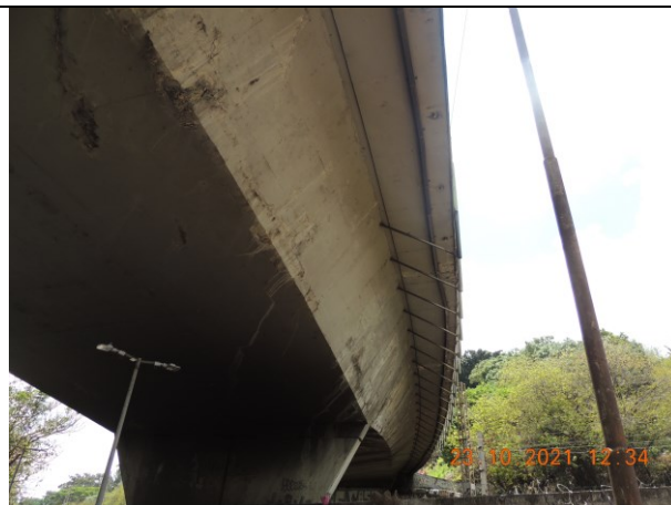
Figura 22. Manchas de eflorescências na região inferior do tabuleiro decorrente da percolação de água pela estrutura do viaduto Dona Helena Greco
