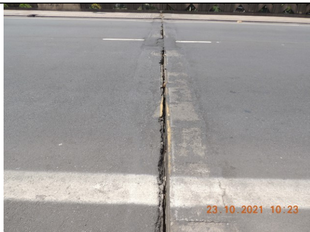
Figura 23. Falhas na vedação das juntas de dilatação favorecem a percolação de água pela estrutura do viaduto Santa Tereza (vista superior)
