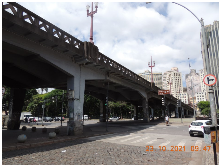
Figura 8. Vista lateral do viaduto Santa Tereza
