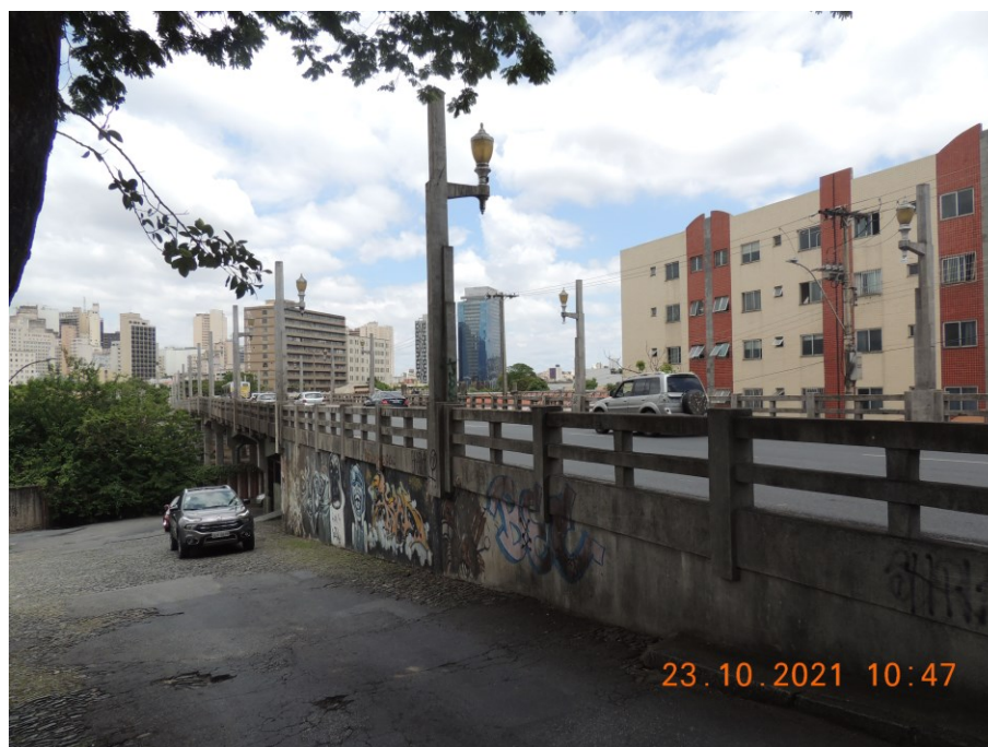
Figura 9. Vista lateral do viaduto Floresta
