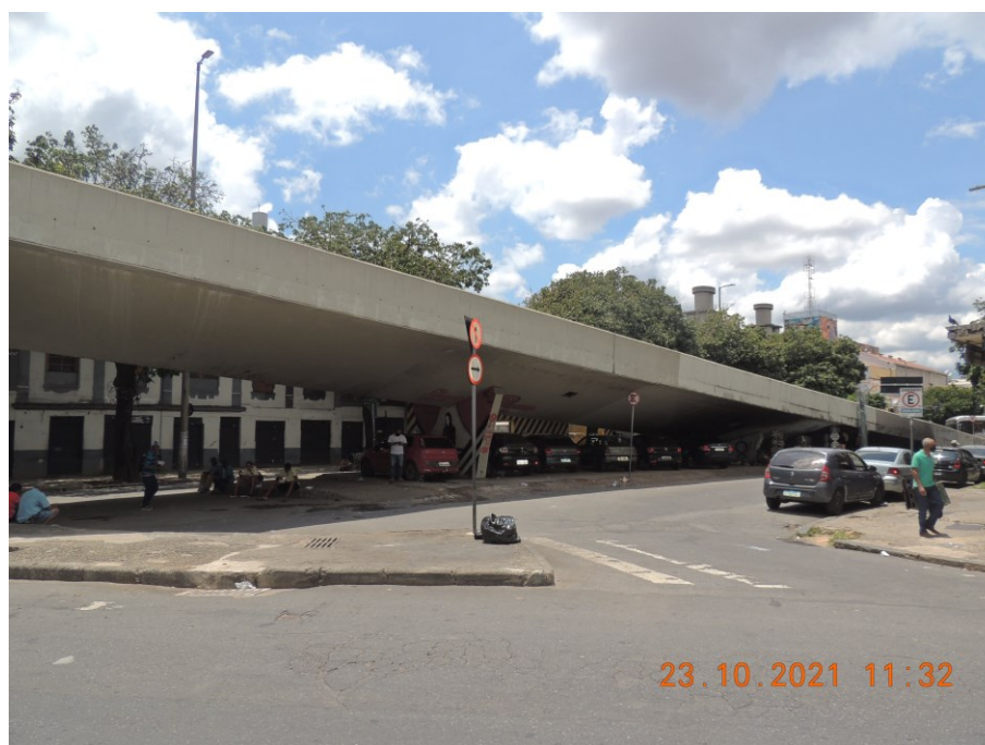
Figura 10. Vista lateral do viaduto Nansén Araújo
