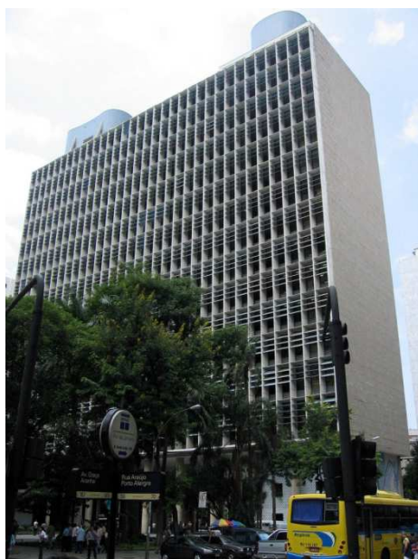
Figura 7 – Brise misto/ Palácio Gustavo Capanema -Fonte: http://commons.wikimedia.org/wiki
