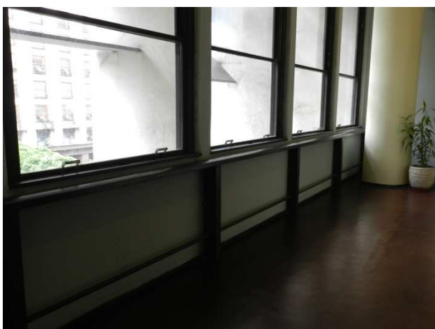
Figura 35 - Fachada Noroeste / Vista interna Caixilharia móvel – PGC, Rio de Janeiro Fonte: Acervo próprio
