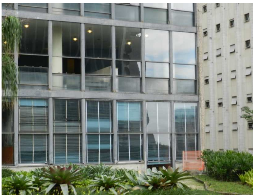
Figura 32 - Fachada Sudeste – Persianas / Palácio Gustavo Capanema, Rio de Janeiro Fonte: Acervo pessoal
