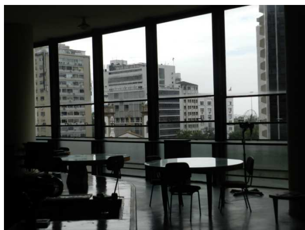
Figura 36 - Fachada Sudeste / Vista interna - Caixilharia móvel – PGC, Rio de Janeiro Fonte: Acervo próprio
