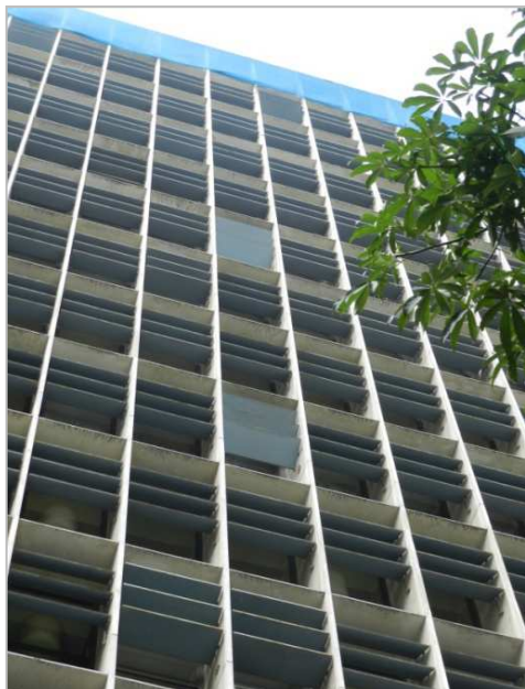
Figura 28 - Sistema de proteção solar Palácio Gustavo Capanema, Rio de Janeiro Fonte: Acervo pessoal
