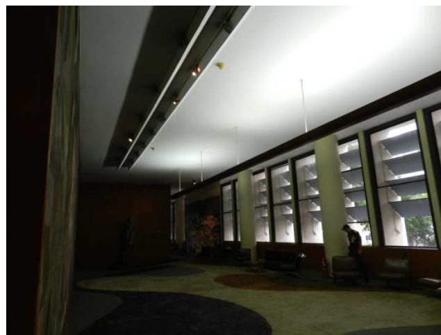
Figura 43 - Brise existente posicionado na angulação de 45° - Fonte: Acervo próprio
