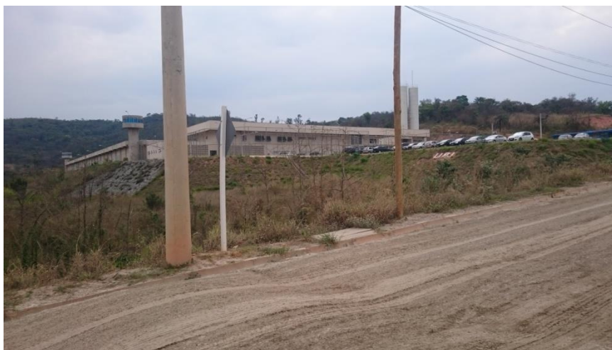
Fotografia 1 – Complexo Penitenciário Público-Privado de Ribeirão das Neves/MG
