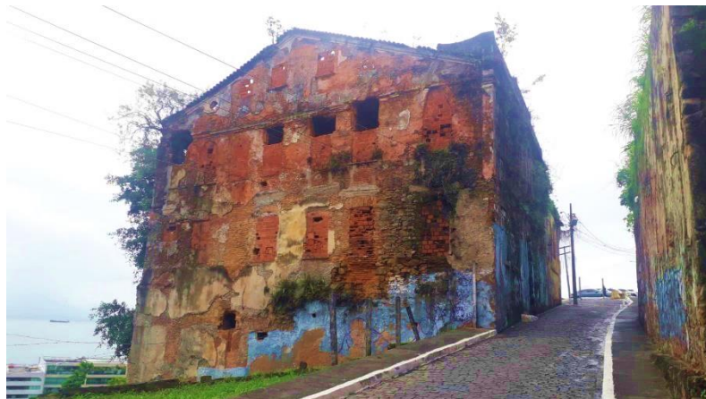
Foto 2: Ruínas de prostíbulo na rua da Gameleira (antiga zona boêmia) e fachada pintada pelos moradores. Preguiça, Salvador, 2023.
