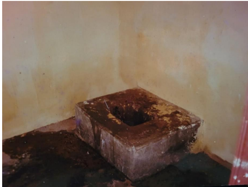
Figura 22: Banheiro da escola
