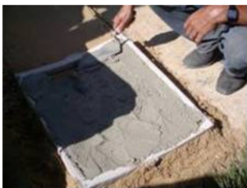
Figura 3.6 – Confeção das placas da parede e da viga de sustentação da cobertura da cisterna, respectivamente.
