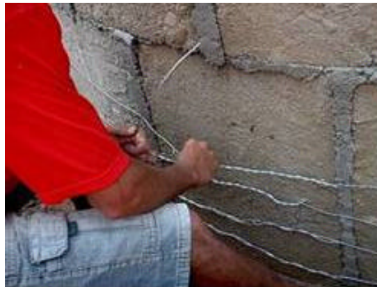
Figura 3.10 – Amarração das paredes com arame.
