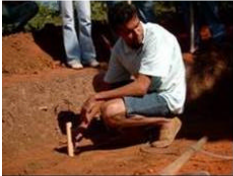
Figura 3.8 – Nivelamento do contrapiso.
