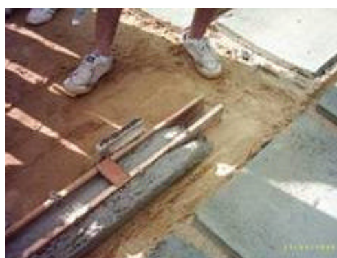
Figura 3.6 – Confeção das placas da parede e da viga de sustentação da cobertura da cisterna, respectivamente.
