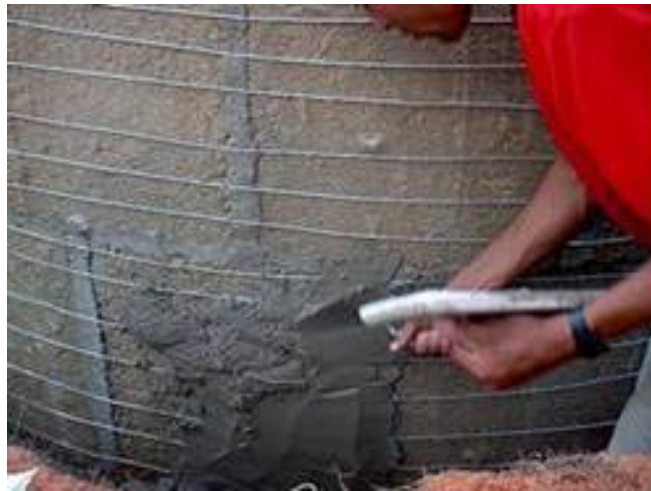
Figura 3.11 – Reboco externo das paredes.
