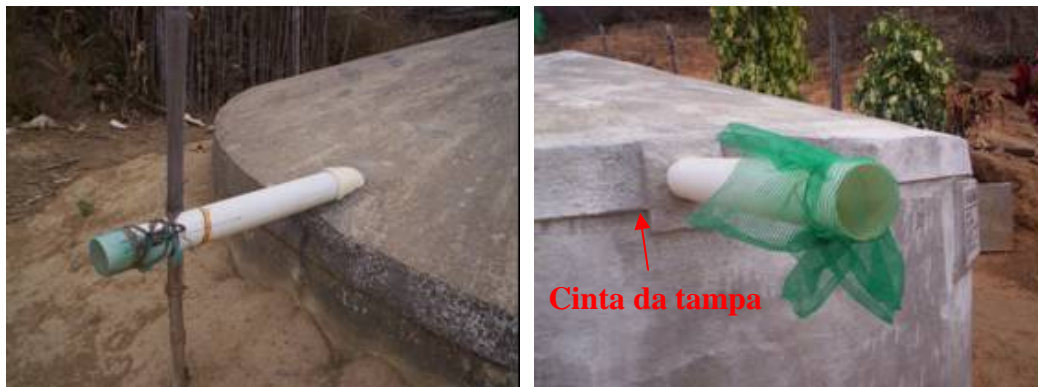
Figura 5.5 – Localização do extravasor da cisterna.
