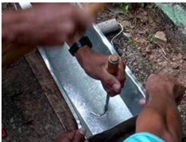
Figura 3.14 – Confeção da calha de zinco.
