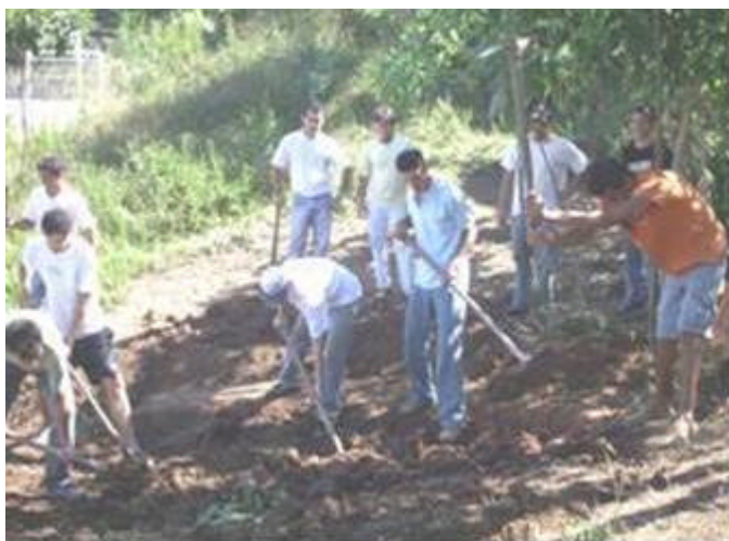
Figura 3.5 – Início da escavação do buraco para construção da cisterna.
