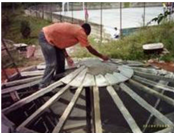
Figura 3.12 – Colocação da cobertura da cisterna.
