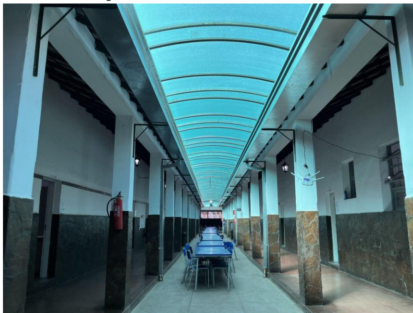
Imagem 11 – Visão interna da Escola da Usina
