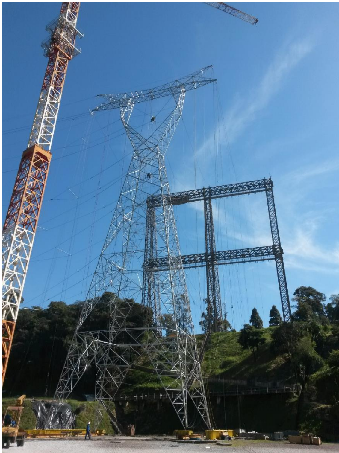
Figura 1 - Torre ensaiada na empresa SAE Tower em Betim.
