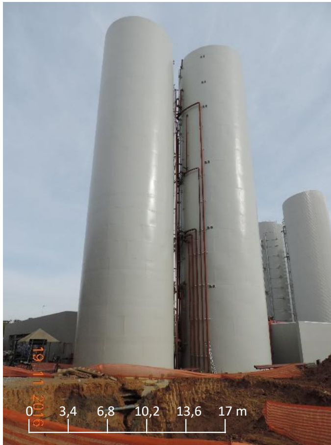
FIGURA 34: Reservatório apoiado de 1.070 m 3 RESERVATÓRIO ELEVADO 4.
