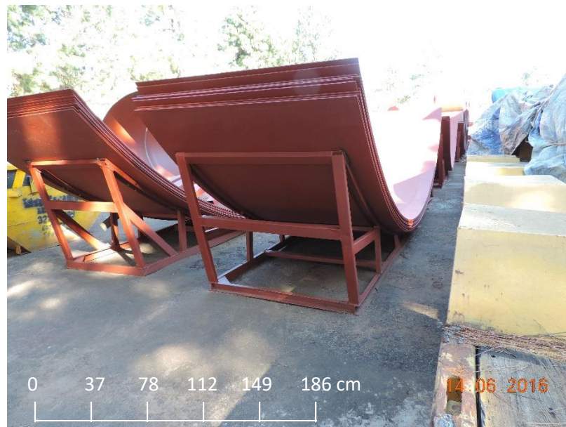
FIGURA 11: Condicionamento das chapas calandradas.
