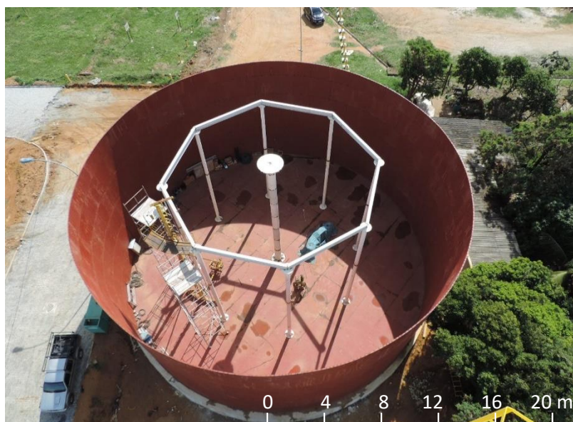
FIGURA 28: Montagem do reservatório apoiado de 3.878 m 3 (RESERVATÓRIO APOIADO 2).
