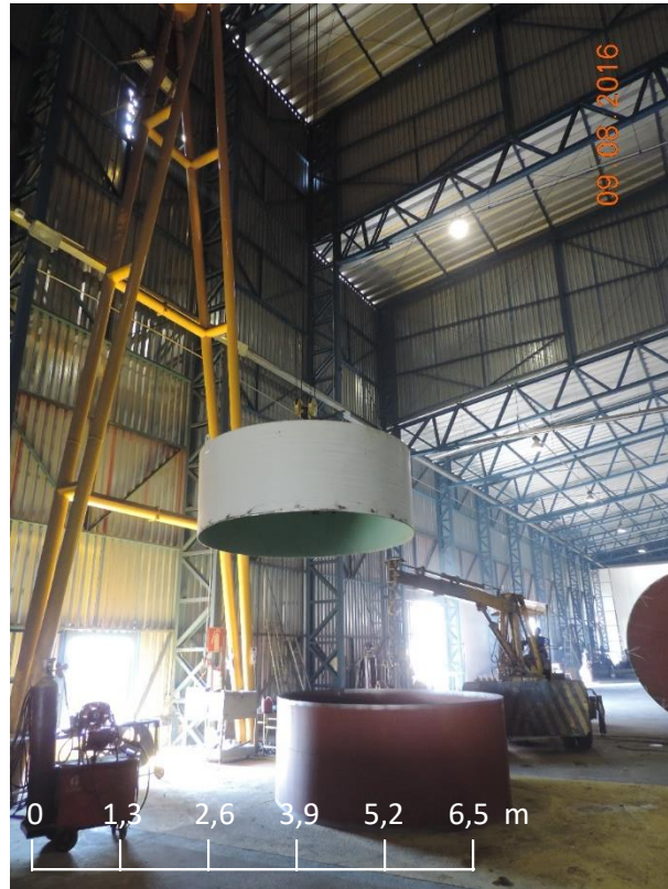
FIGURA 13: Acoplamento vertical dos anéis.
