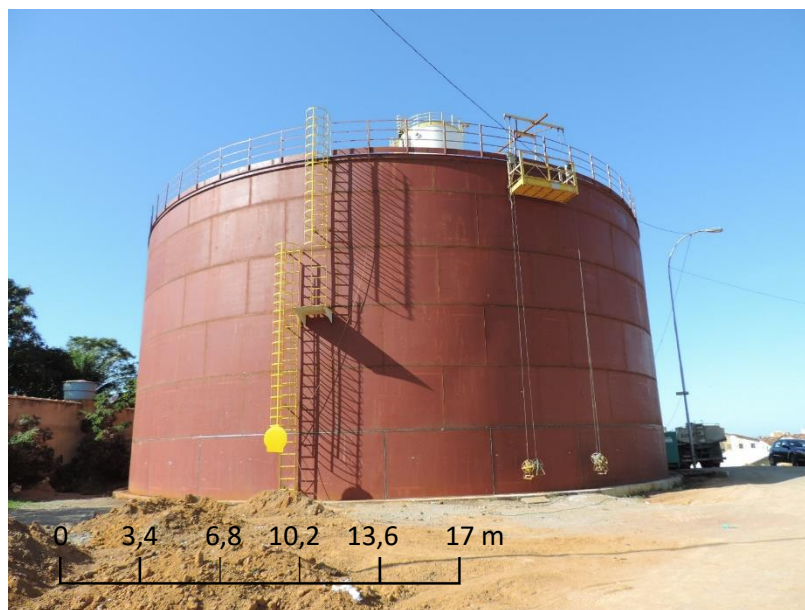
FIGURA 29: Soldagem do reservatório apoiado de 3.878 m 3 - RESERVATÓRIO APOAIDO 2).
