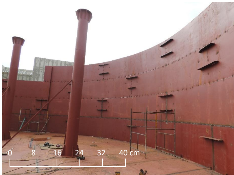
FIGURA 31: Montagem do reservatório apoiado de 1.200 m 3 - RESERVATÓRIO APOIADO 3.
