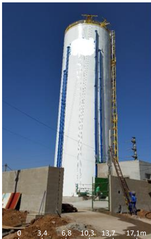
FIGURA 27: Acabamento final -RESERVATÓRIO ELEVADO 1.
