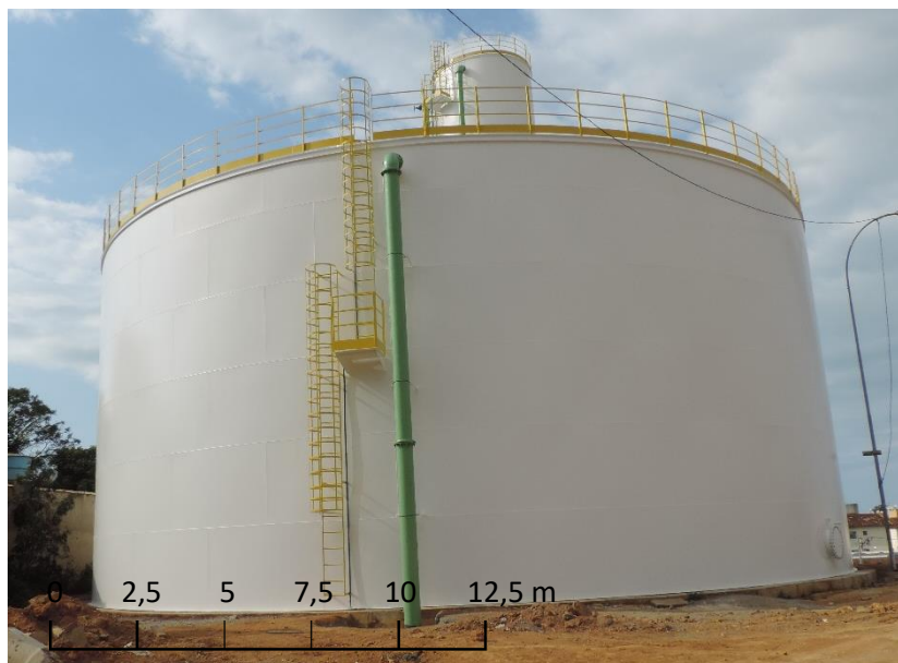
FIGURA 30: Reservatório apoiado de 3.878 m 3 - RESERVATÓRIO APOAIDO 2.
