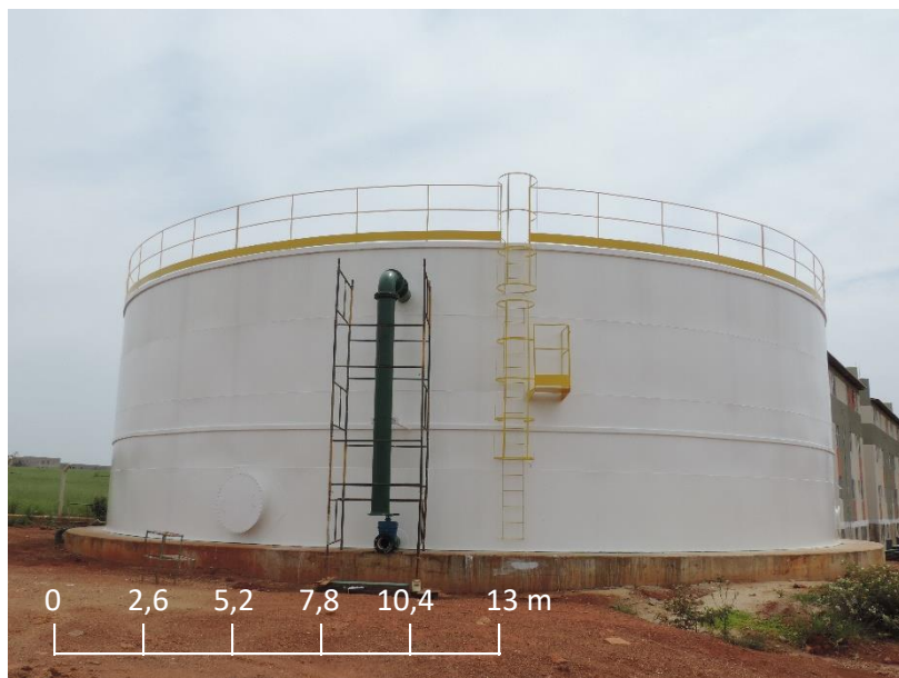
FIGURA 33: Reservatório apoiado de 1.200 m 3 (RESERVATÓRIO APOIADO 3. Fonte: Próprio autor.
