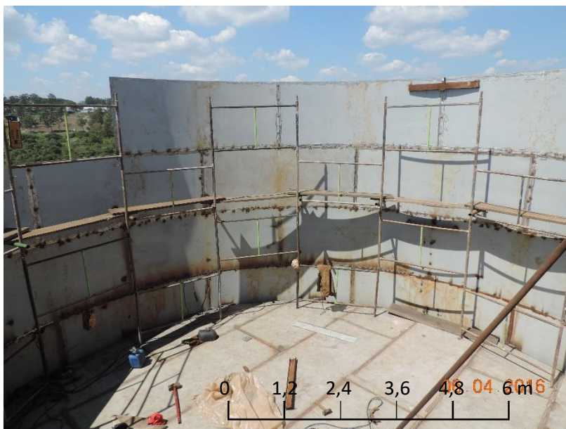
FIGURA 25: Montagem do reservatório elevado construído em campo- RESERVATÓRIO ELEVADO 1.
