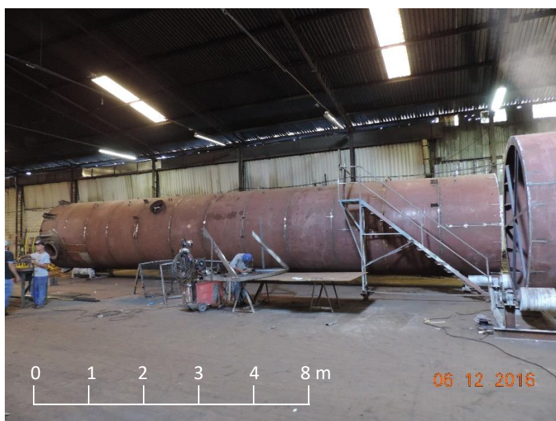
FIGURA 36: Reservatório elevado montado em fábrica- RESERVATÓRIO ELEVADO 5.
