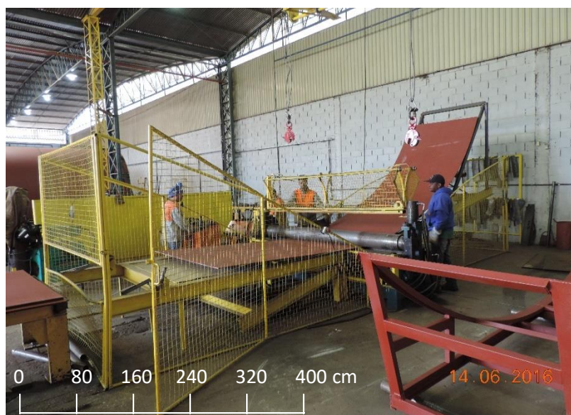
FIGURA 10: Calandramento de chapas.
