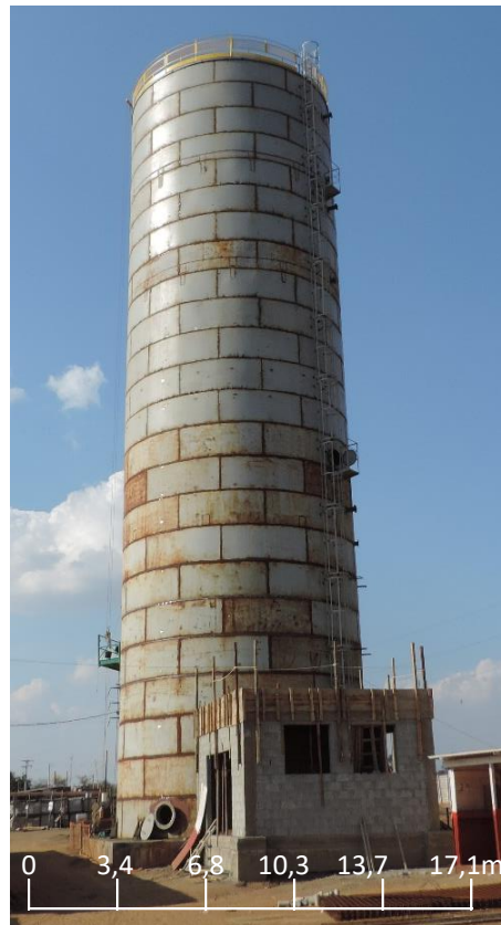
FIGURA 26: Soldagem do reservatório - RESERVATÓRIO ELEVADO 1.
