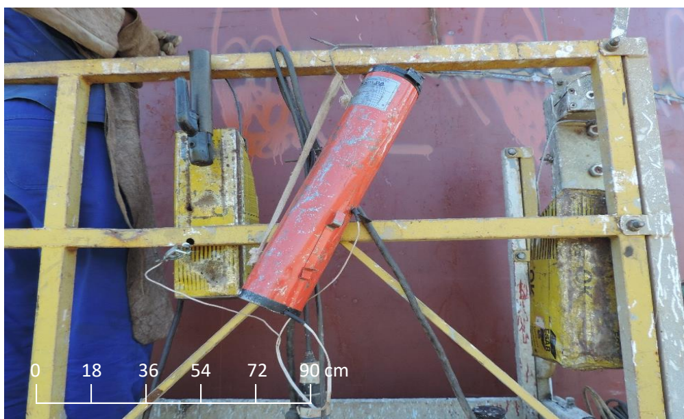
FIGURA 24: Condicionamento adequado dos eletrodos.
