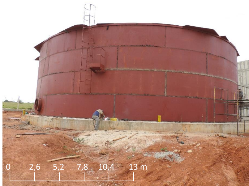
FIGURA 32: Soldagem do reservatório apoiado de 1.200 m 3 - RESERVATÓRIO APOIADO 3.
