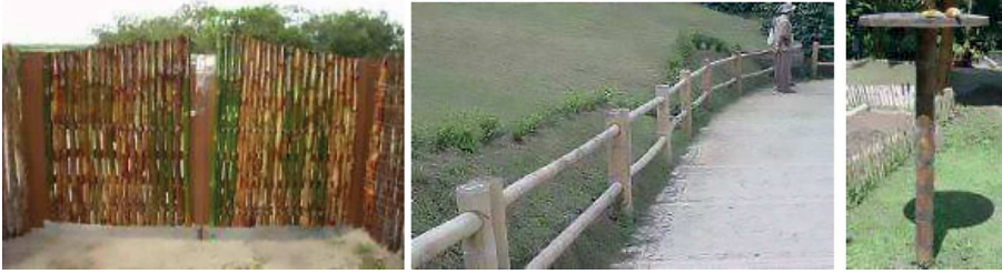
Figura 2. Uso inadequado do bambu: exposto às intempéries e em contato direto com o solo: curta vida útil.
