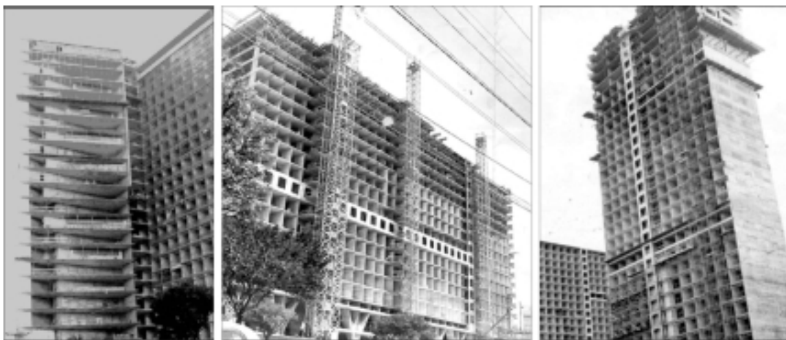
FIGURA 25 – Fotos da construção do conjunto JK.
