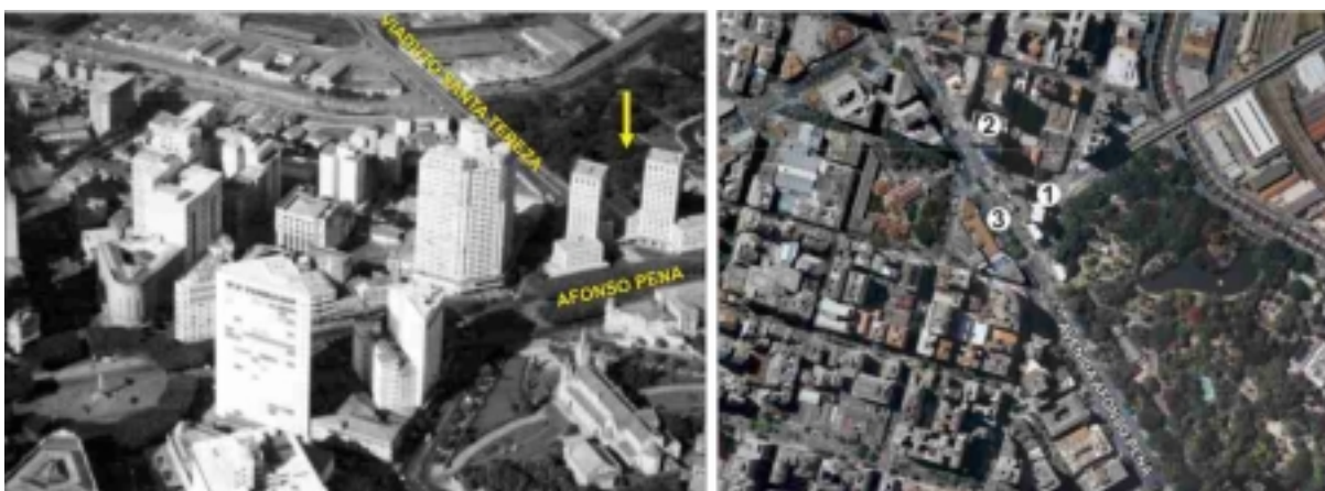
FIGURA 22 – A implantação do Edifício Sulacap Sudameris e entorno imediato: (1) Ed. Sulacap-Sudameris; (2) Ed. Acaiaca e (3) Localização do anexo construído na década de 70.
