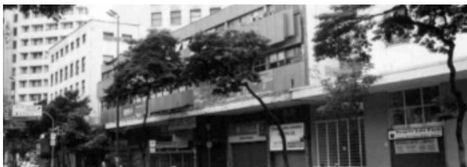
FIGURA 23 – Anexo construído em frente ao edifício Sulacap-Sudameris.
