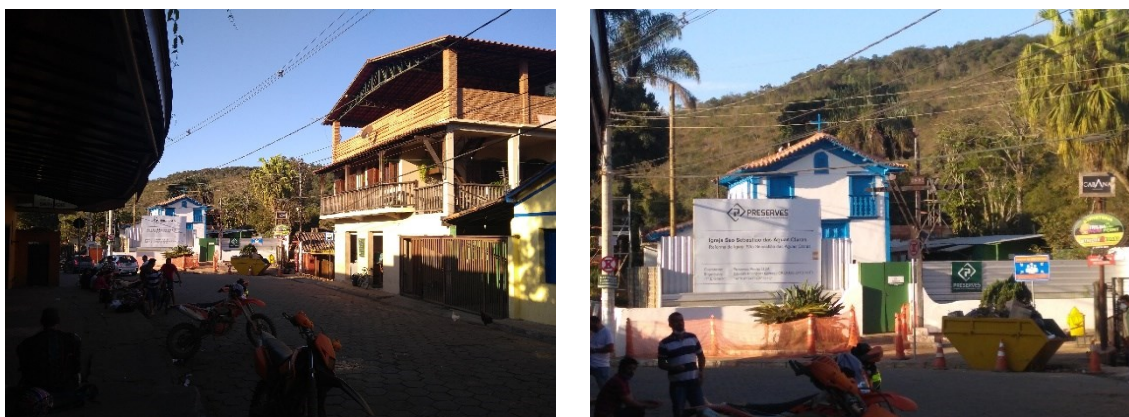
Figura 65: Na visão do observador o ponto de encontro da comunidade e a capela colonial em obras, respectivamente.
