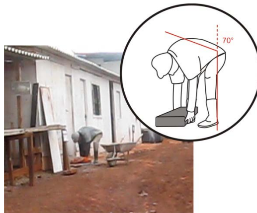
Figura 1. Fotografia do operador realizando flexão anterior de tronco de 70^\circ ao manusear saco de cimento.
