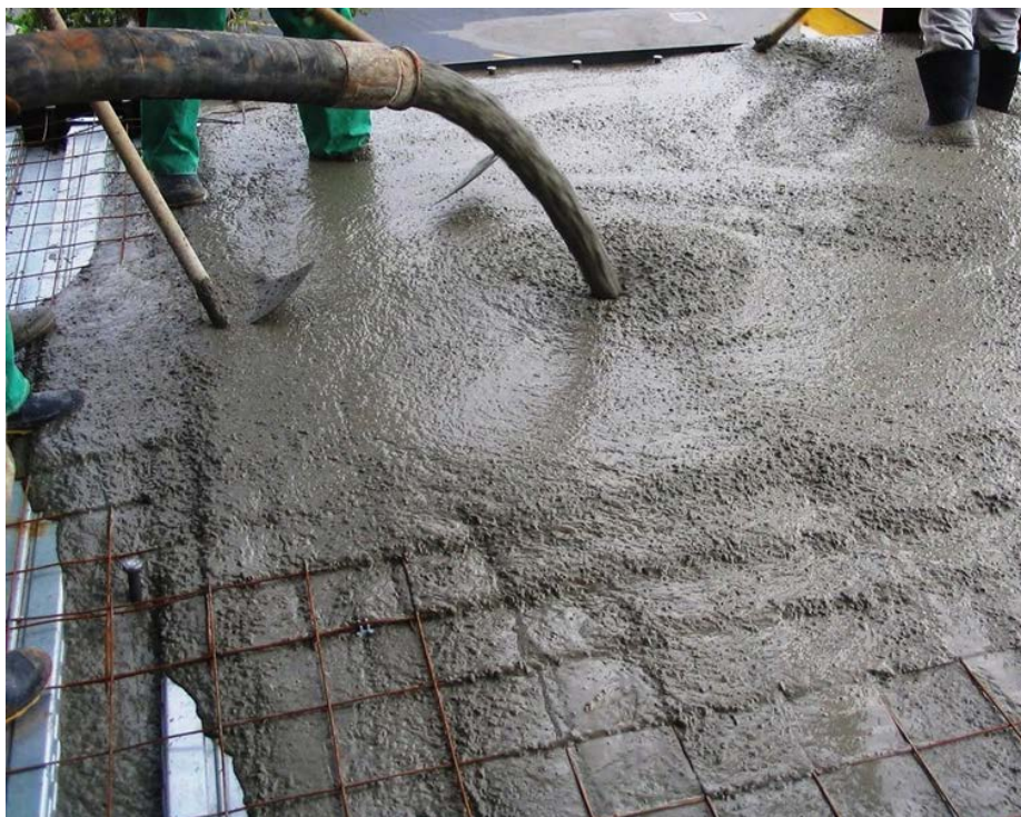
Figura 7 Utilização do cimento CP-III nas estruturas.
