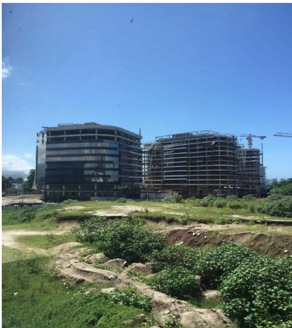
Figura 3 Construção do Bloco 1 e 2.
