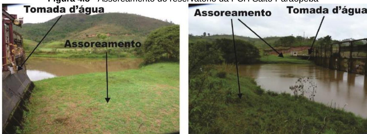
Figura 4.8 - Assoreamento do reservatório da PCH Salto Paraopeba
