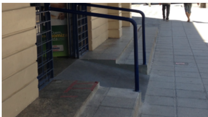
Figura 22. Rebaixamento de piso. Fonte: Foto tirada pelo próprio autor deste trabalho (2018).
