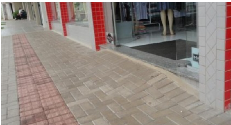
Figura 21. Elevação de calçada para cobrir pequeno degrau. Fonte: Foto tirada pelo próprio autor deste trabalho (2018).
