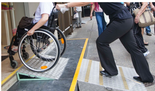
Figura 11. Rampas móveis demasiadamente inclinadas exigem que outra pessoa auxilie o cadeirante.
