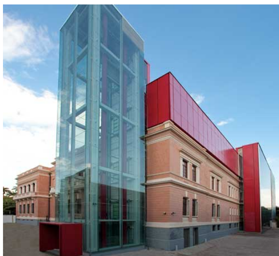
Figura 7. Elevador de acesso ao museu. Fonte: Google imagens (2017).
