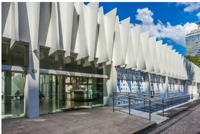
Figura 4. Rampa de acesso à entrada do primeiro museu visitado. Fonte: Google imagens (2018).
