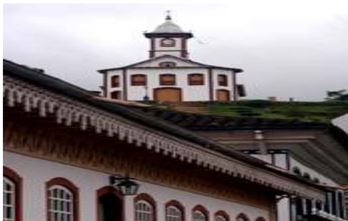
Foto 131: Restauro de imóveis privados Fonte: site: www.monumenta.gov.br
