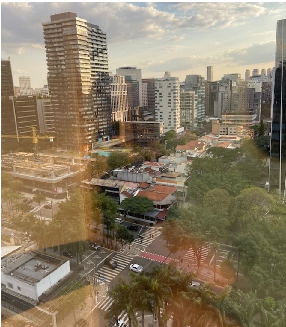
Fotografia 51 - Terrenos em preparação para o adensamento no bairro Vila Olímpia
