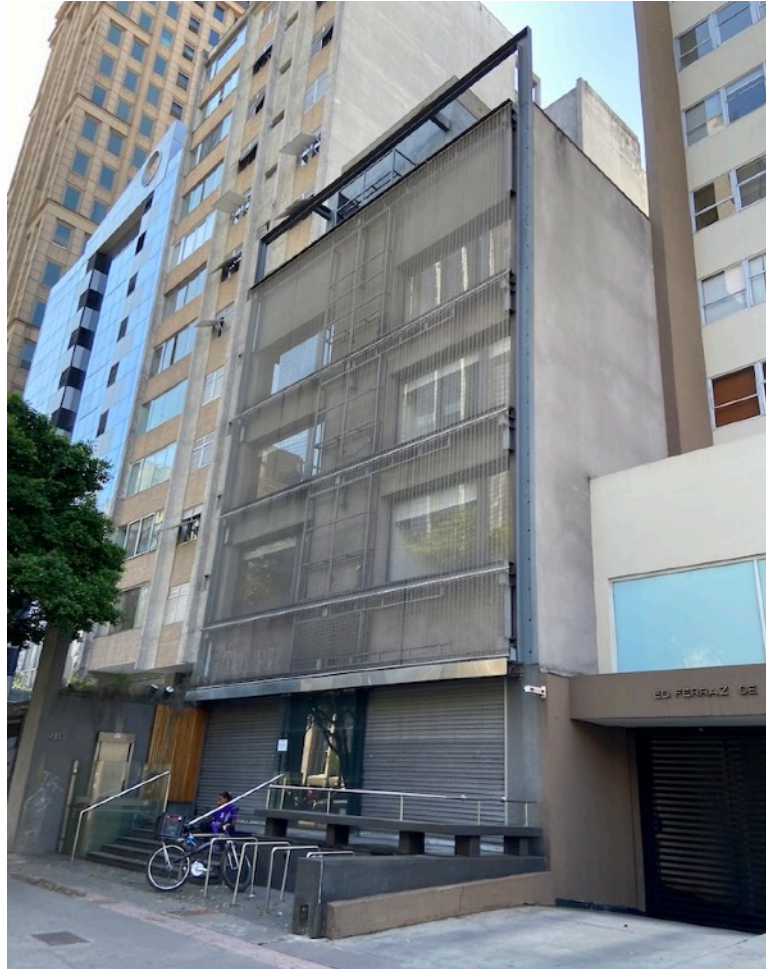
Figura 13 - Edifício que modernizou a sua fachada por meio de um retrofit
