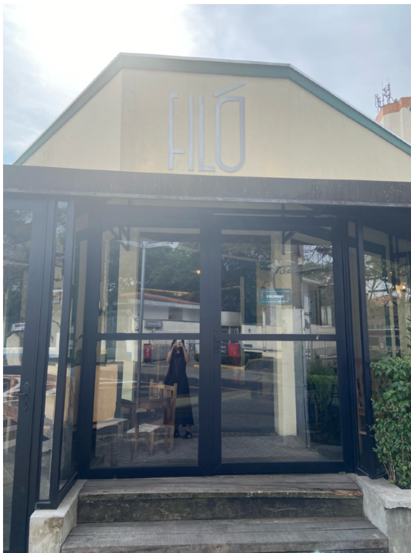
Fotografia 81 - Detalhe da fachada de vidro do restaurante Filó
