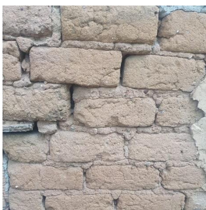
Figura 3 – Muro de adobe
