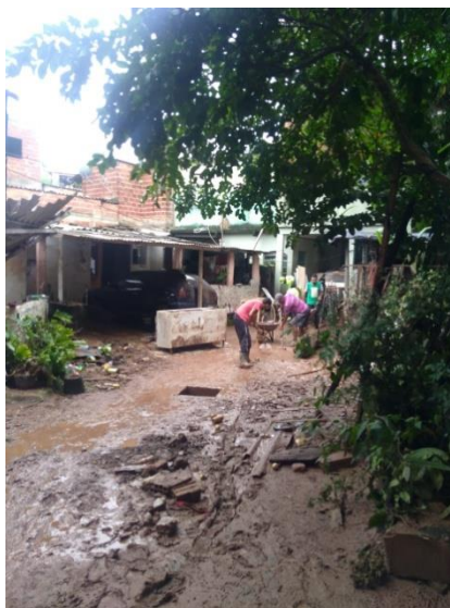
Figura 6 – Barraco destruído pela enchente de 2020
