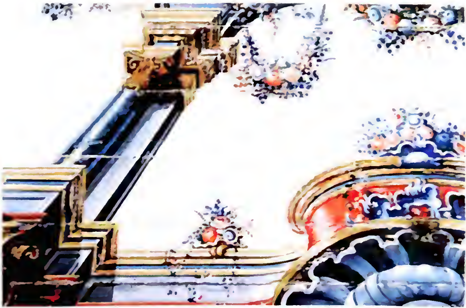
FIGURA 27 - Foto de detalhe do forro da Matriz de São Miguel do Cajuru
