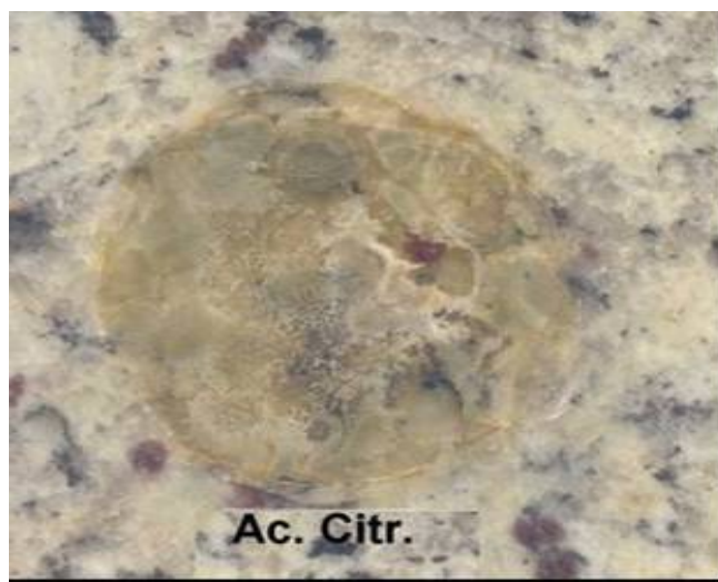
Figura VII.22: Amarelamento da superfície, aspereza e microfissuras evidenciadas, formação de camada oleosa, formação de microcavidades e superfície rugosa após ensaio de alterabilidade com ácido cítrico no Branco Eliane
