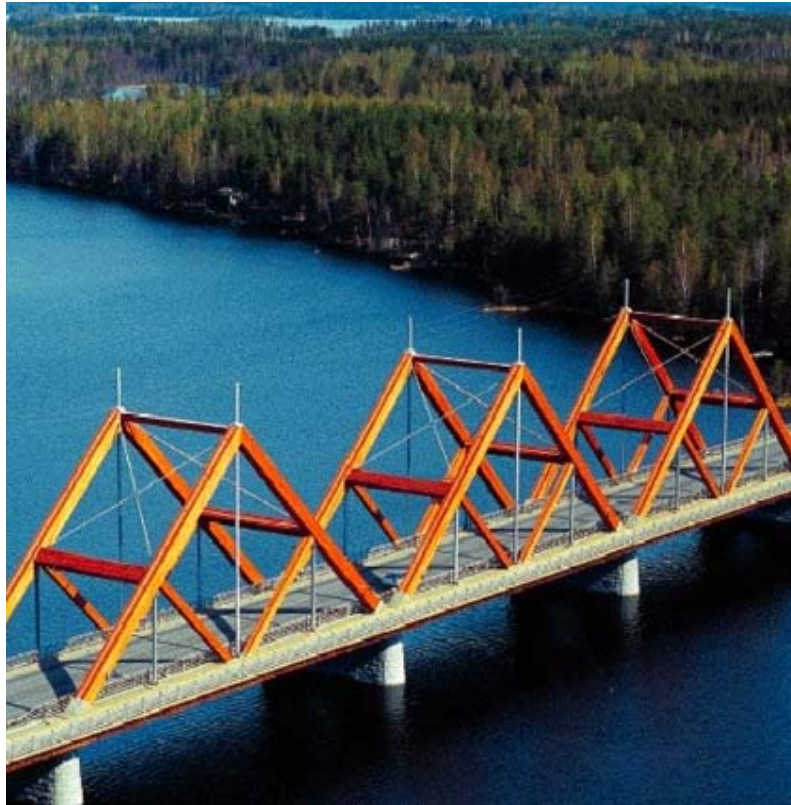
FIGURA 4 – Ponte Vihantasalmi – Finlândia. Fonte: home page de MESTRA Engineering Ltd.
