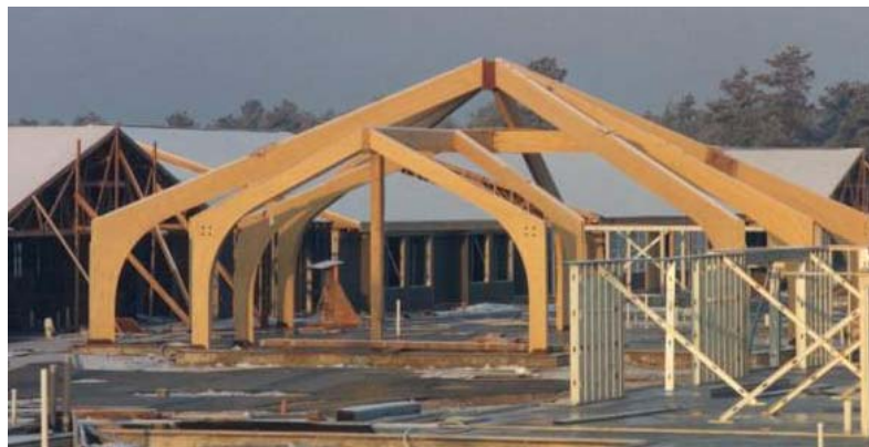
FIGURA 3 – Estrutura aporticada em MLC. Fonte: UNALAM (2002)
