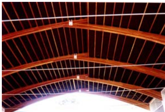
FIGURA 1 – Estrutura com arcos de MLC para cobertura de hangar para helicóptero. Fonte: ESTRUTURAL (2001)
