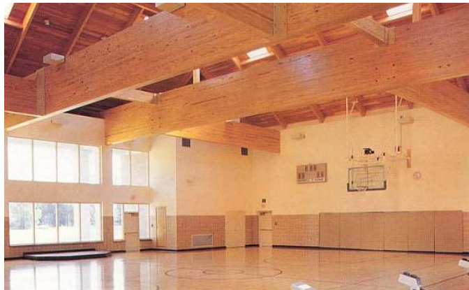
FIGURA 2 – Cobertura de ginásio esportivo utilizando vigas de MLC. Fonte: UNALAM (2002).
