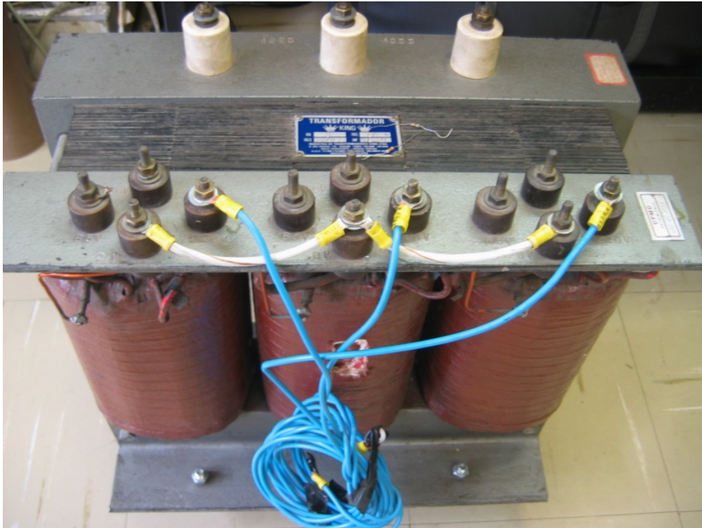
Figura 64: Fotografia mostrando o esquema de ligação dos cabos terminais de conexão.
