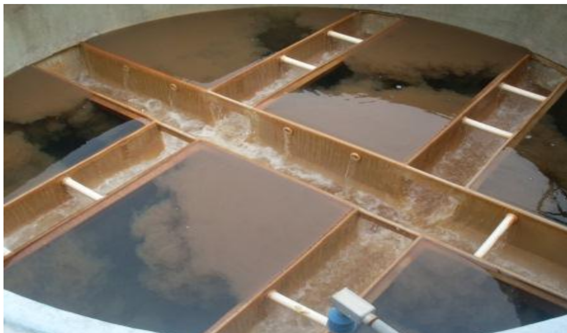
Figura 2- Módulo de dupla filtração de seção circular
