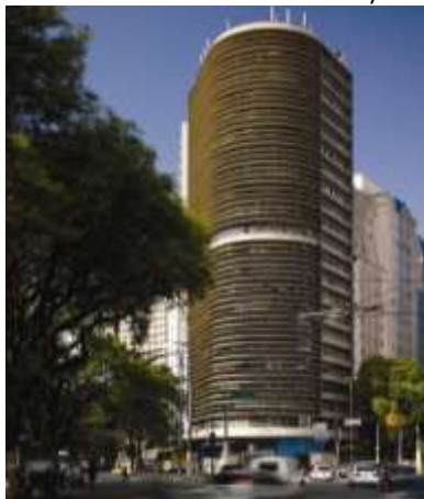
Figura 10 Edifício Residencial Multifamiliar Montreal (São Paulo) com destaque para os dispositivos horizontais de proteção (ângulos vertical de sombreamento)
