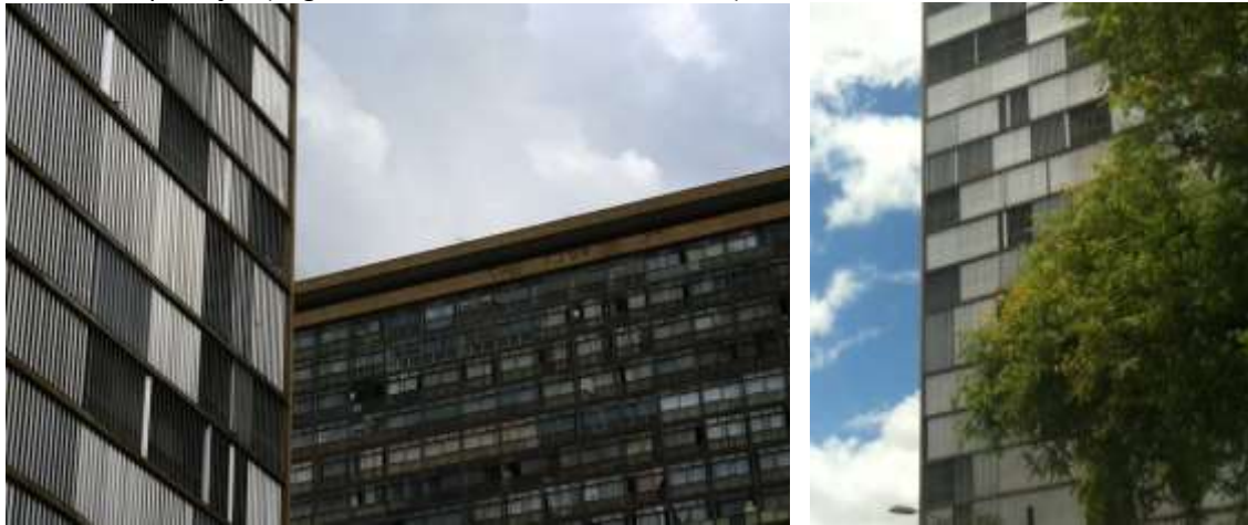
Figura 13 Edifício Residencial Multifamiliar JK (Belo Horizonte/MG) com destaque para os dispositivos verticais de proteção (ângulos horizontais de sombreamento)
