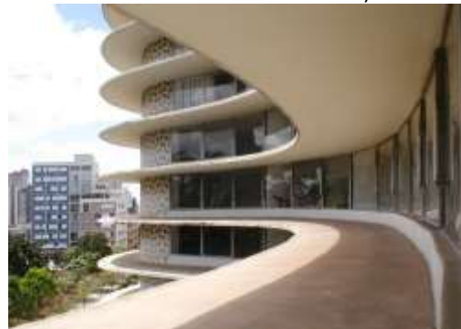
Figura 5 Edifício Residencial Multifamiliar Niemeyer (Belo Horizonte) com destaque para os dispositivos horizontais de proteção (ângulos vertical de sombreamento)
