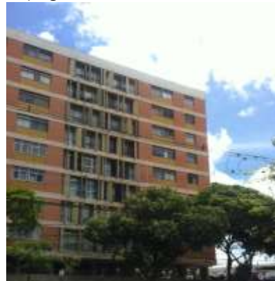
Figura 12 Edifício Residencial Multifamiliar (Belo Horizonte/MG) com destaque para os dispositivos verticais de proteção e autossombreamento (ângulos horizontal de sombreamento)
