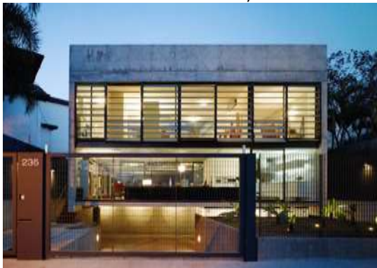
Figura 4 Edifício Residencial Unifamiliar (Boaçava - São Paulo) com destaque para os dispositivos horizontais de proteção (ângulos vertical de sombreamento)
