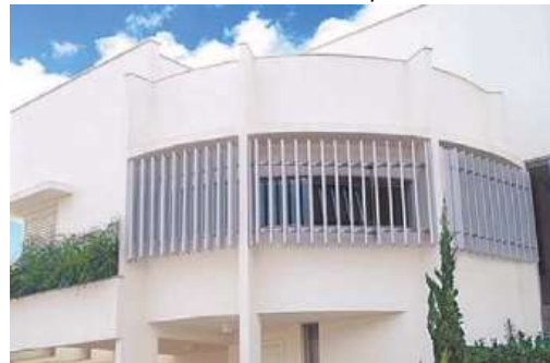
Figura 7 Edifício Residencial Unifamiliar (Belo Horizonte) com destaque para os dispositivos verticais de proteção (ângulos horizontal de sombreamento)
