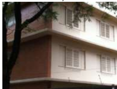
Figura 9 Edifício Residencial Multifamiliar (Belo Horizonte) com destaque para os dispositivos horizontais de proteção (ângulos vertical de sombreamento) e venezianas.
