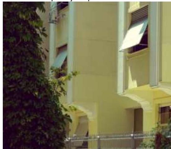
Figura 15 Edifício Residencial Unifamiliar (Belo Horizonte/MG) com destaque para os dispositivos de proteção tipo venezianas
