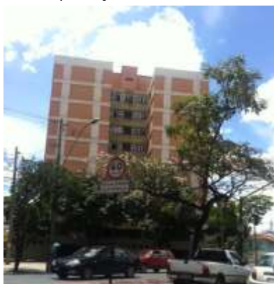
Figura 12 Edifício Residencial Multifamiliar (Belo Horizonte/MG) com destaque para os dispositivos verticais de proteção e autossombreamento (ângulos horizontal de sombreamento)
