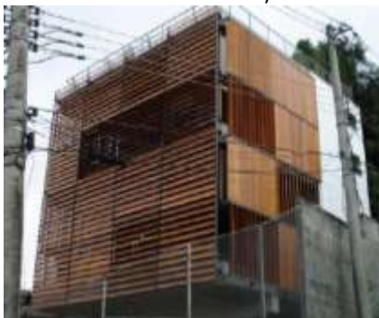
Figura 8 Edifício Residencial Unifamiliar (Rio de Janeiro) com destaque para os dispositivos verticais de proteção (ângulos horizontal de sombreamento)
