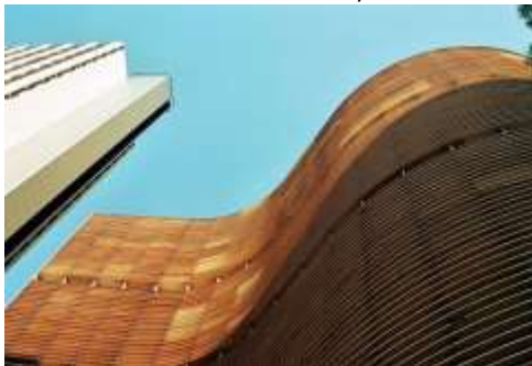
Figura 6 Edifício Residencial Multifamiliar Copan (São Paulo) com destaque para os dispositivos horizontais de proteção (ângulos vertical de sombreamento)
