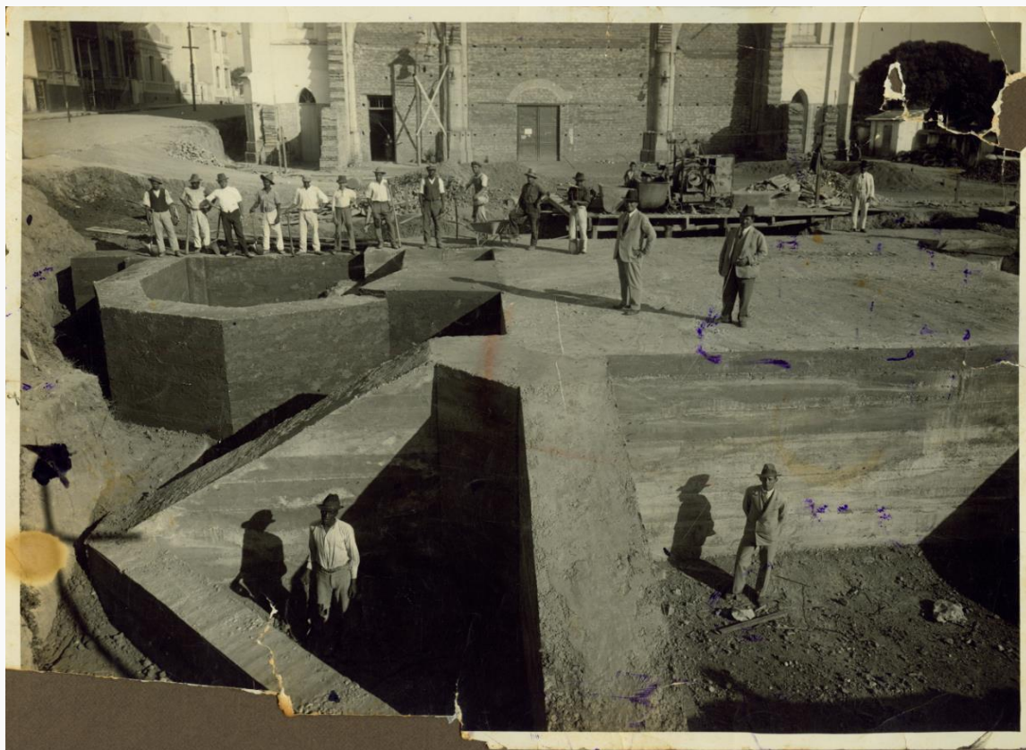
Fig. 10: Canteiro de obras de edifício público em Belo Horizonte.
