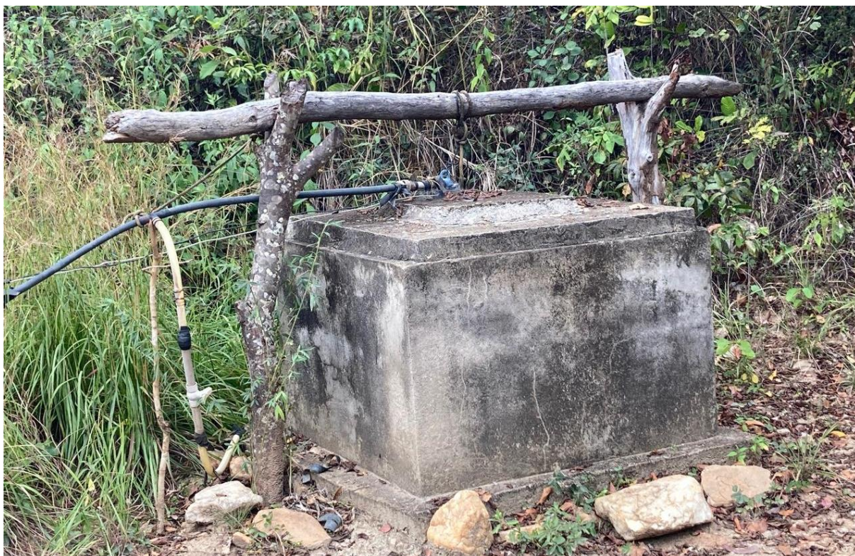
Foto (Galizoni, 2023): Cisterna cavada/cisterna manual, na comunidade de Cuba, município de Chapada do Norte, médio Jequitinhonha.
