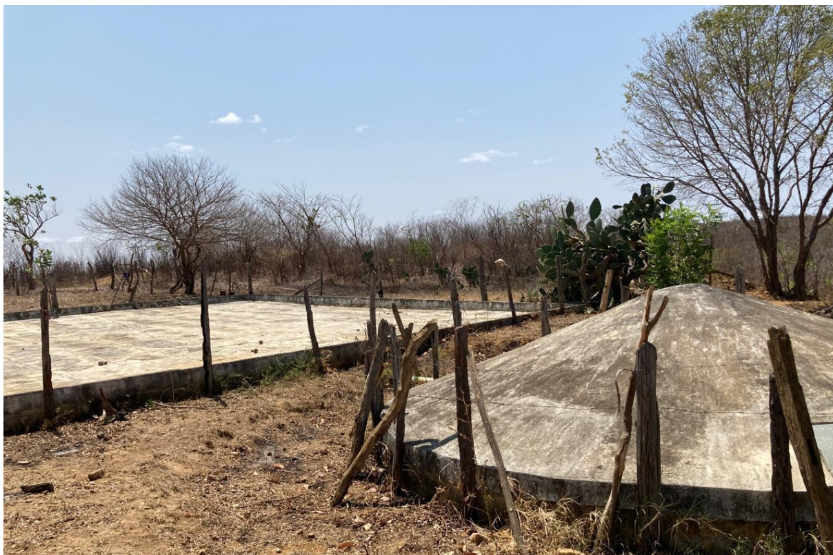
Foto (Galizoni, 2023): Cisterna de Calçadão/Terreirão, do Programa Uma Terras e Duas Águas – P1+2, na comunidade de Curuto, município de Araçuaí, médio Jequitinhonha.
