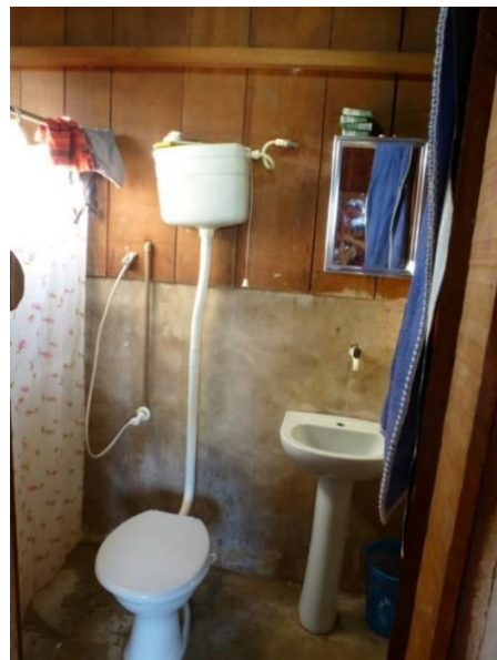
Figura 5.3: Banheiro com vaso sanitário, pia e chuveiro
