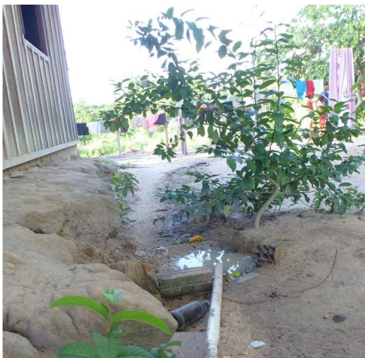
Figura 5.7: Disposição de água servida diretamente no solo
