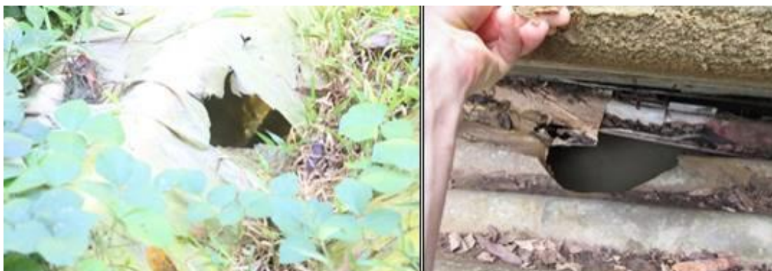
Figura 5.58: Duas fossas cheias com presença de mosquito e/ou mau cheiro
