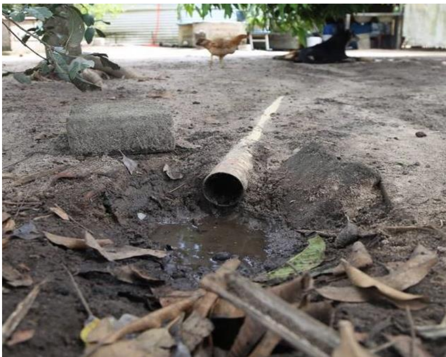
Figura 5.46: Disposição de águas cinzas no solo
