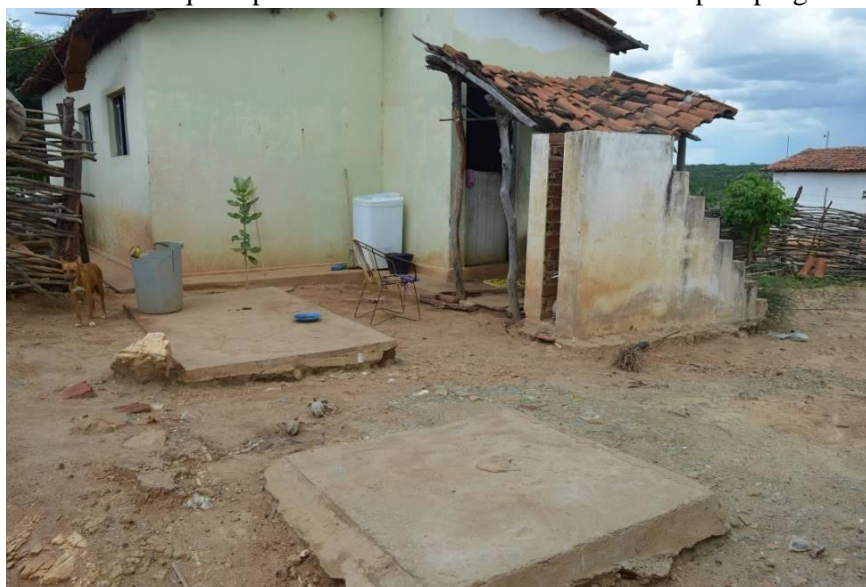
Figura 5.30 - Sistema tanque séptico e sumidouro da casa construído pelo programa da FUNASA
