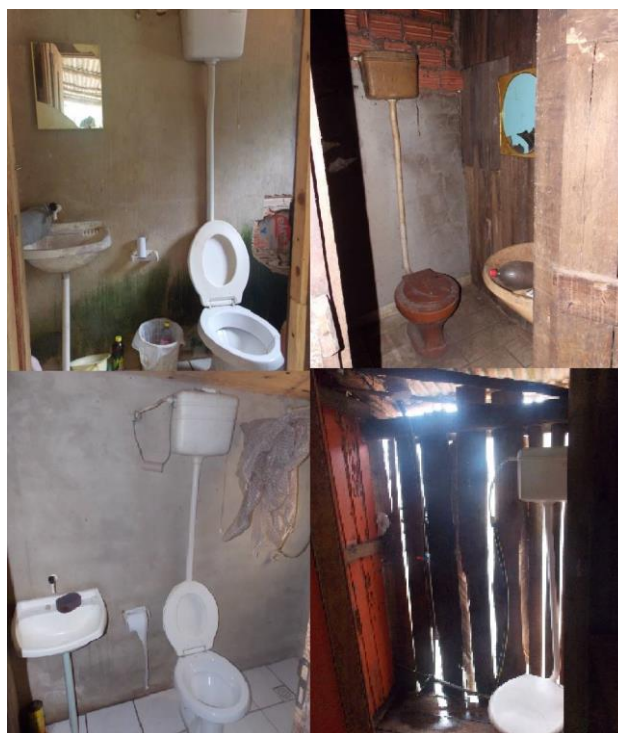
Figura 5.63 - Banheiros das casas visitadas pela equipe
