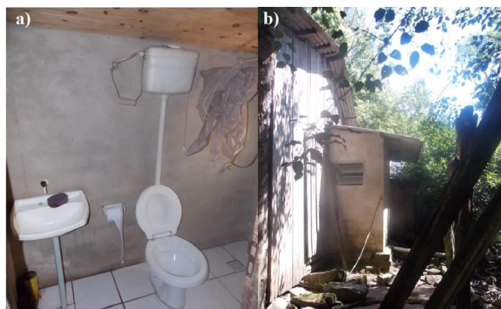
Figura 5.64: Banheiro construído pela prefeitura
