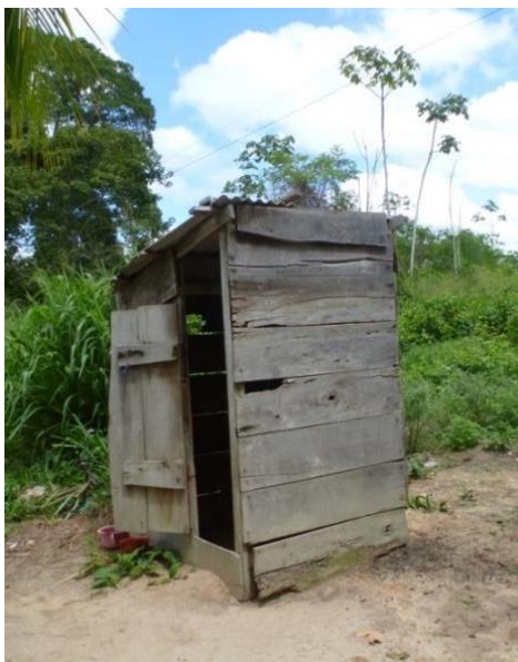
Figura 5.2: Casinha sobre fossa seca de um dos domicílios
