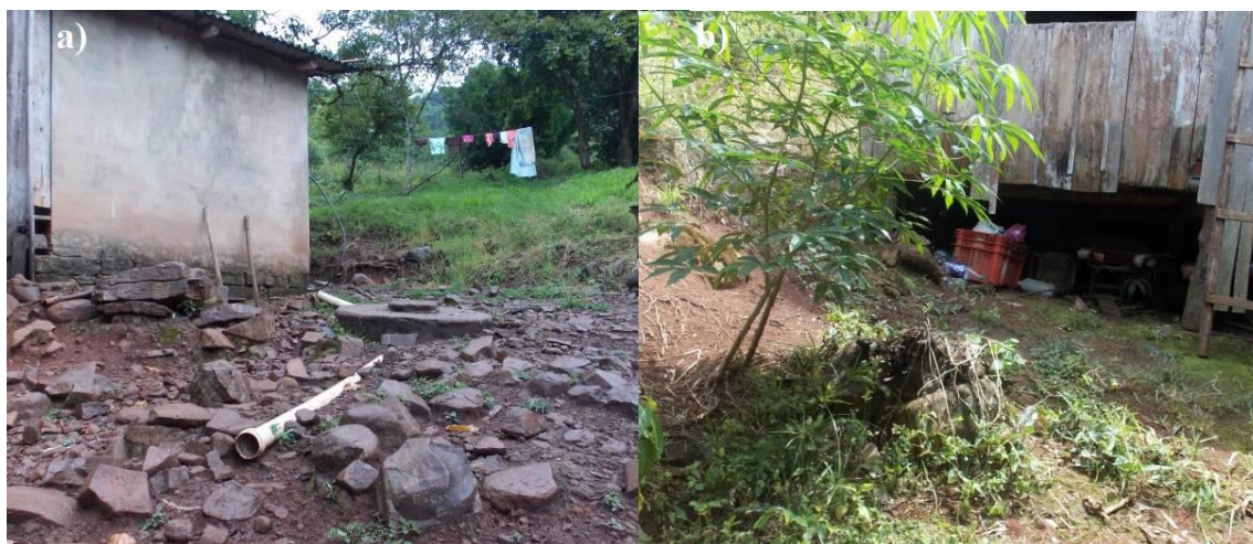
Figura 5.62: Fossa construída pela prefeitura e por morador
