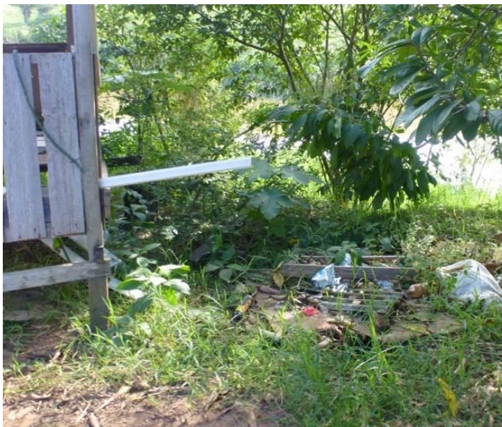
Figura 5.11: Vista da tampa da fossa, no lote, a cerca de 20m da casa
