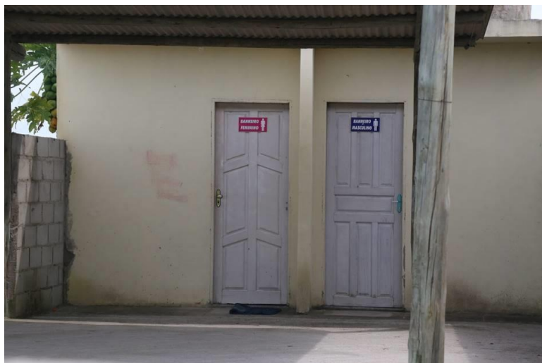
Figura 5.47 - Banheiro para uso dos fiéis da igreja local
