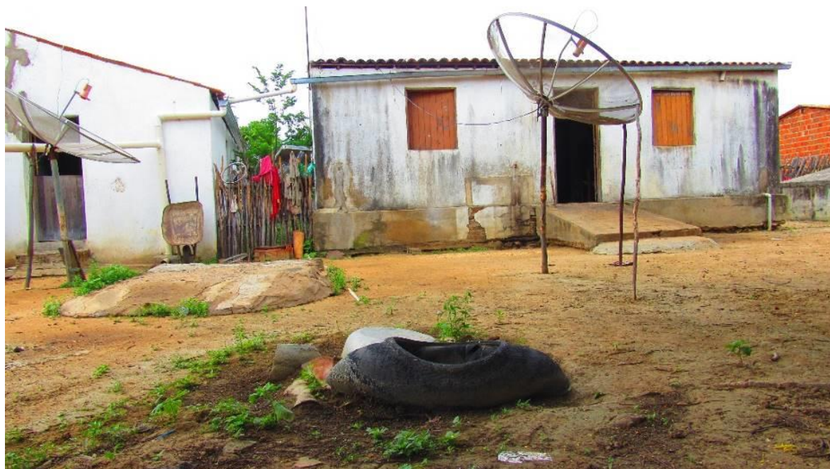
Figura 5.20: Local de construção de uma fossa absorvente por morador
