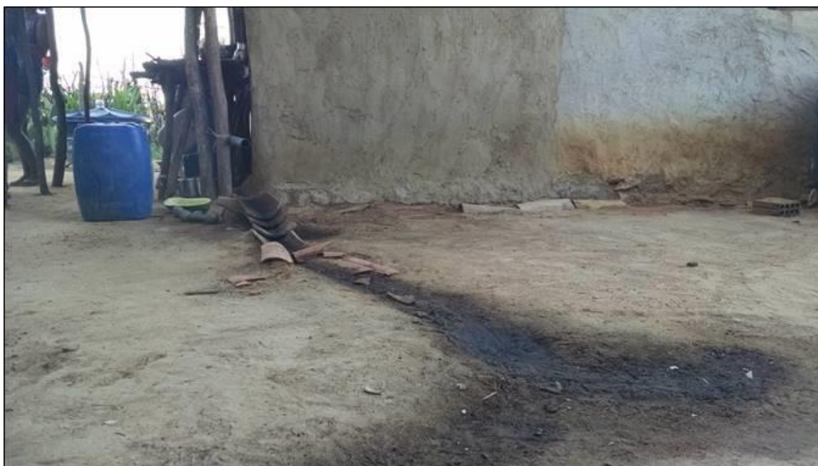
Figura 5.35: Fotografia do quintal da casa da BA8, com foco na viela de escoamento da água da pia, utilizada para lavagem de roupa e vasilhas
