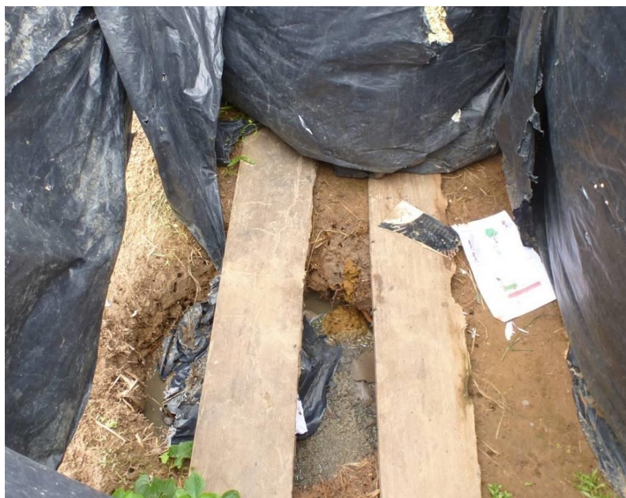
Figura 5.15: Alto nível d'água em fossa seca, com apenas cinco meses de uso
