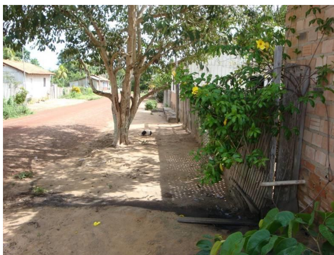
Figura 5.8: Água servida escorrendo pela calçada
