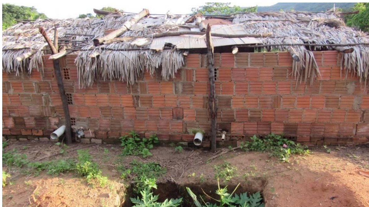
Figura 5.21: Vala em que são dispostas águas cinzas em uma das residências
