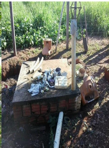
Figura 5.12: Fossa retangular com tampa em concreto
