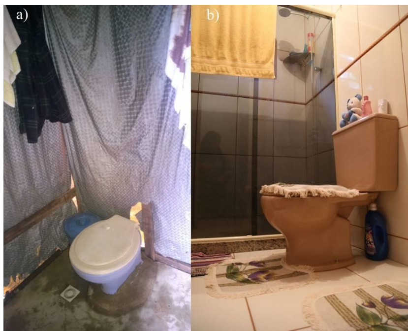
a) Banheiro de um dos moradores em condições precárias de uso; b) Banheiro em melhores condições de salubridade.
