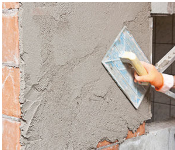
Figura 12: Execução do acabamento
