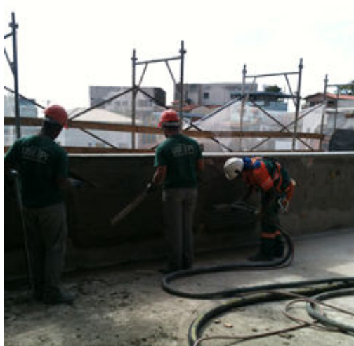
Figura 11: Sarrafeamento executado com régua de alumínio
