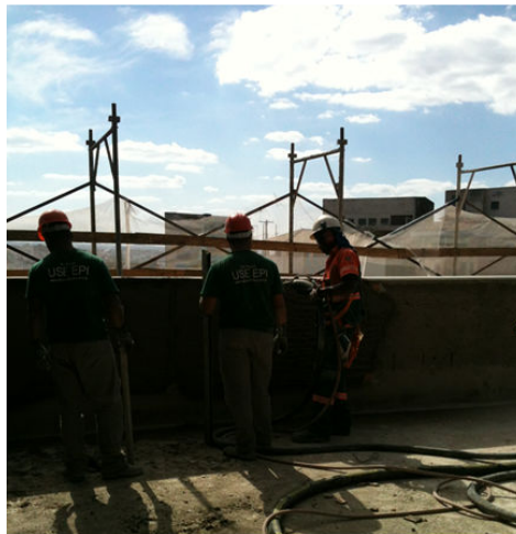
Figura 5: Treinamento de argamassa projetada realizado no canteiro de obras
