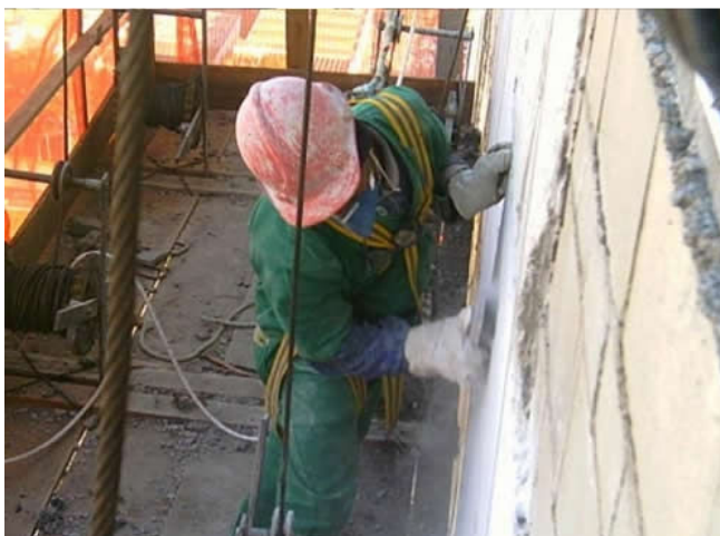
Figura 6: Fase da limpeza grossa da base
