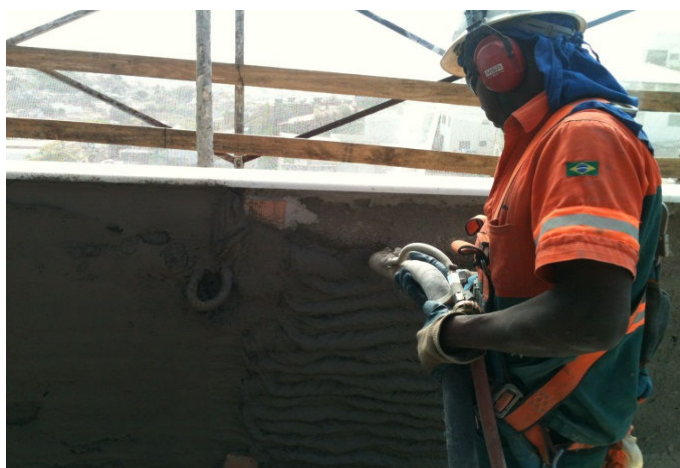
Figura 10: Projeção horizontal da argamassa
