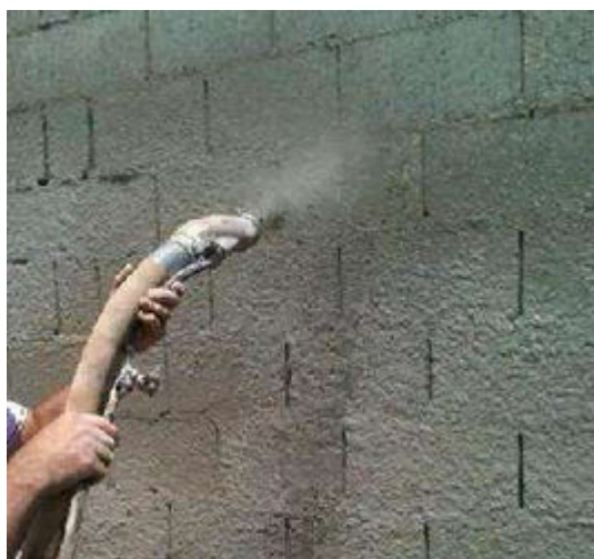
Figura 7: Chapisco projetado
