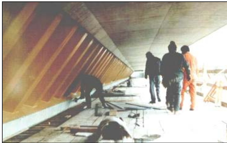
Figura 1.11 – Ponte Cognac na França
