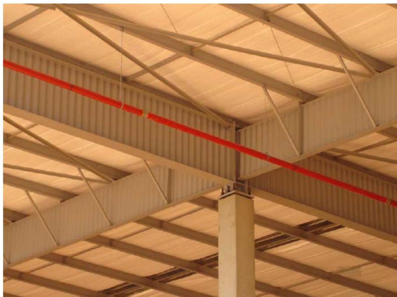
Figura 1.17 – Cobertura com perfil de alma senoidal
