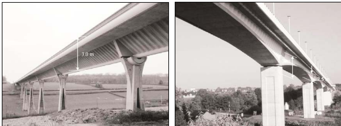
Figura 1.12 – Viaduto Maupré e Ponte Dole na França
