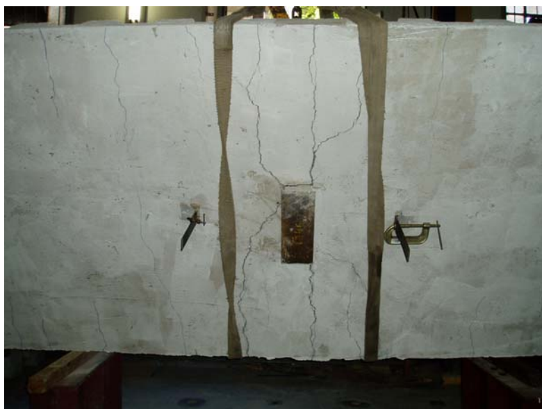
Figura 4.27 – Fissuras na laje de concreto
