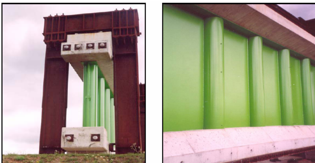
Figura 1.15 - “Viaduct de Franchissement de la Vallée de la Marne”
