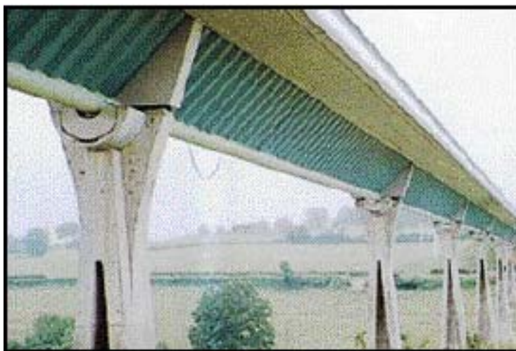
Figura 1.14 – Ponte na Coréia do Sul
