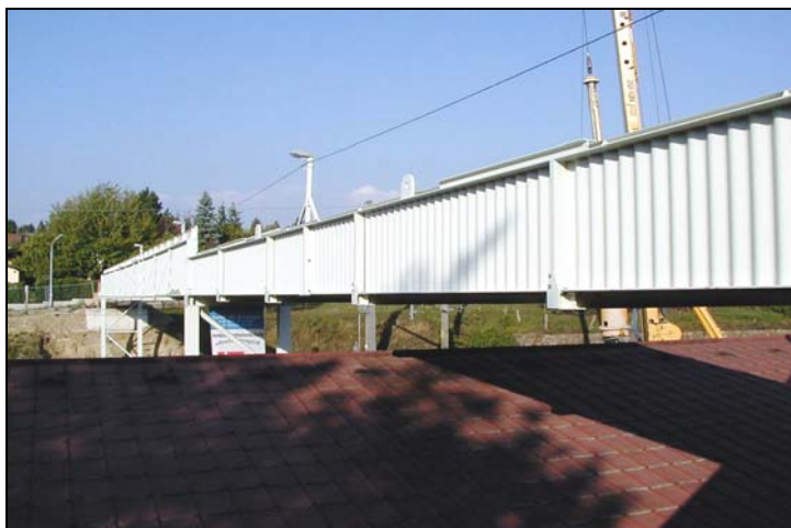
Figura 1.16 – Passarela de pedestres em Viena, Áustria
