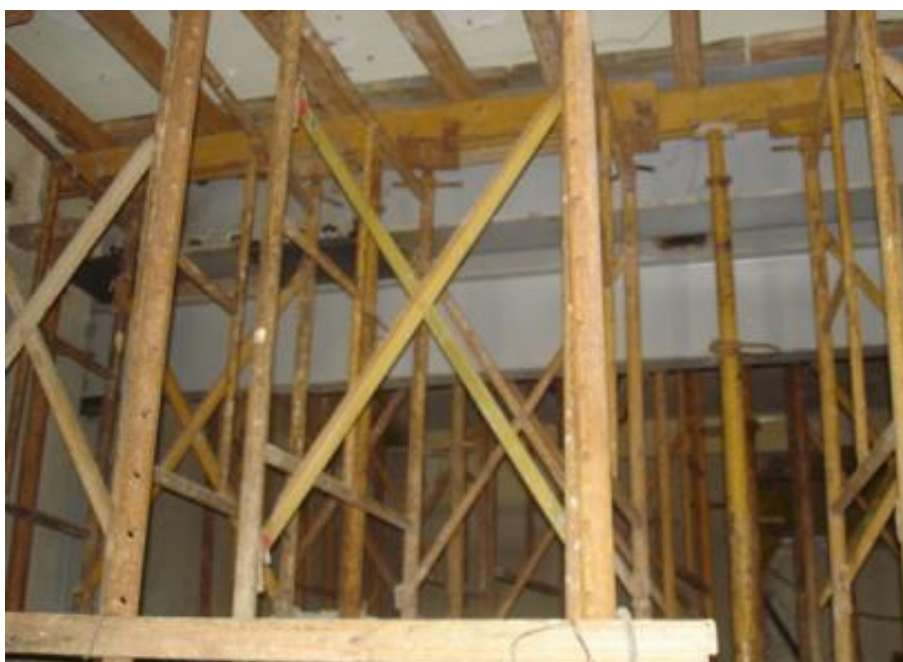
Ilustração 6 – Escoramento e perfil metálico do reforço estrutural na sala de tomografia.
