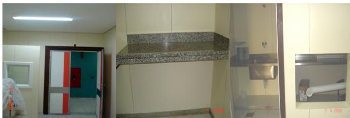
Ilustração 11 - Raio X – 1) Porta com proteção radiológica. 2) Bancada nova de Granito Cinza Corumbá e parede revestida com fórmica. 3) Abertura para equipamento de revelação de filme e bancada em aço inox.
