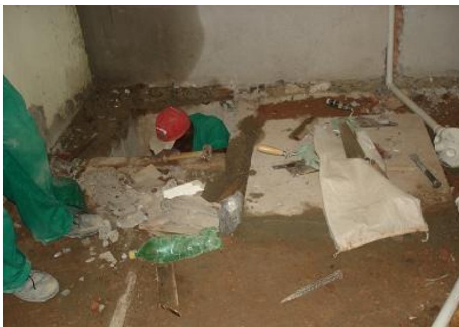
Ilustração 3 – Caixas de passagem de esgoto encontradas sob o piso.
