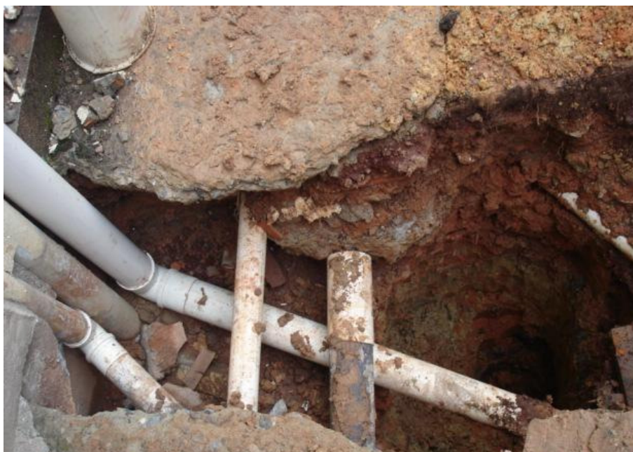
Ilustração 2 Exemplo das diversas instalações encontradas não previstas em projeto
