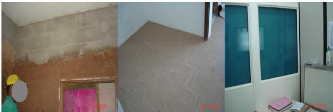
Ilustração 9 - Mamografia – 1) Execução de reboco com barita para proteção radiológica. 2) Novo piso paviflex. 3) Vidro blindado para segurança dos pacientes e funcionários do setor.
