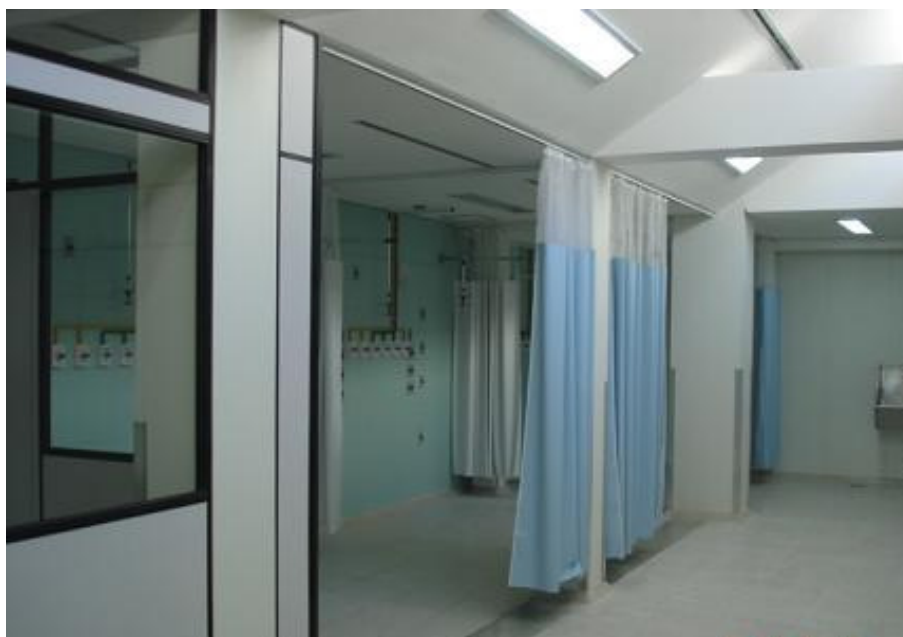
Ilustração 8 – UCI da emergência concluída.
