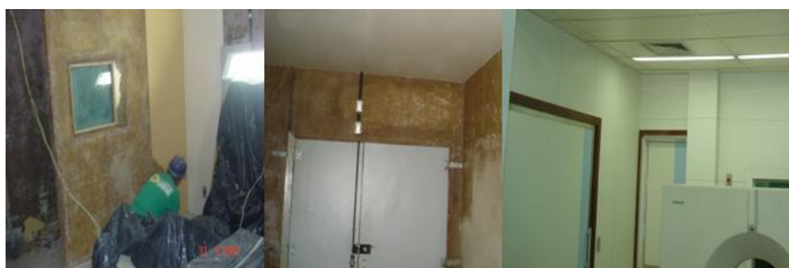
Ilustração 12 - Tomografia – 1) Remoção das fórmicas danificadas para substituição. 2) Porta com proteção radiológica substituída por outra. 3) Conclusão da obra na Tomografia.
